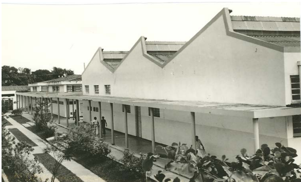
Fotografia 18 - Bloco dos laboratórios (1979) da ETFMT
