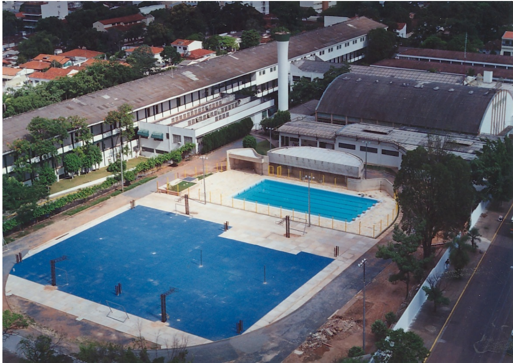
Fotografia 16 - Construção do ginásio da ETFMT
