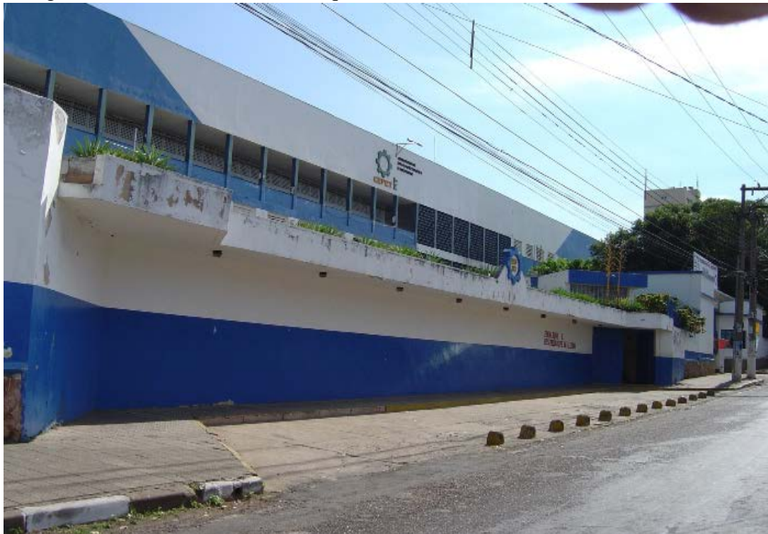
Fotografia 7 - Fachada da escola enquanto funcionou como CEFET-MT
