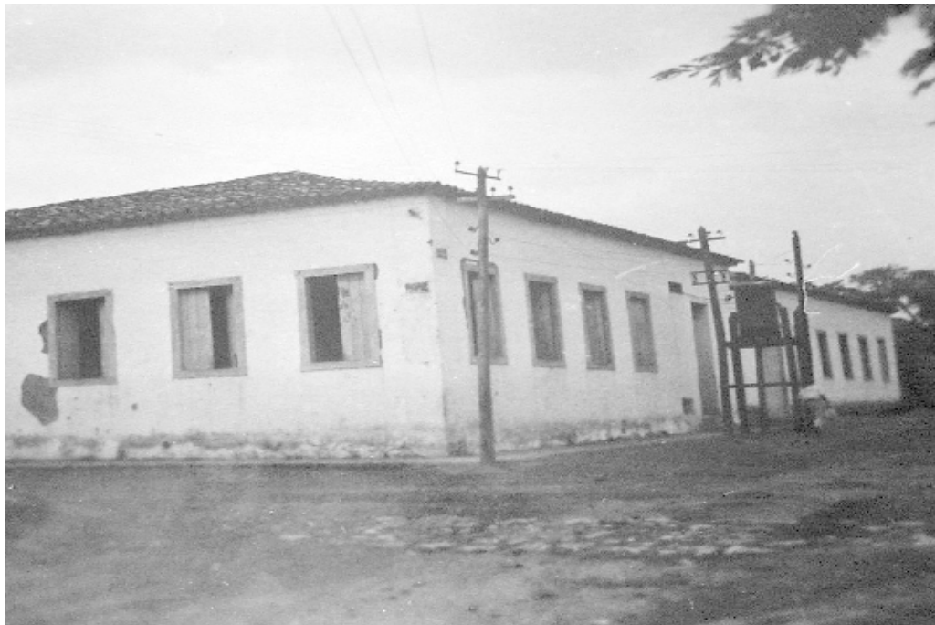
Fotografia 4 - Bloco das oficinas da EAAMT, década de 1920
