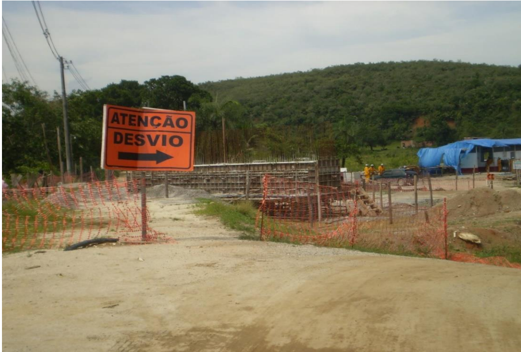
Figura 30: Placa de desvio no acesso às casas dos moradores à margem do Rio Capivari
