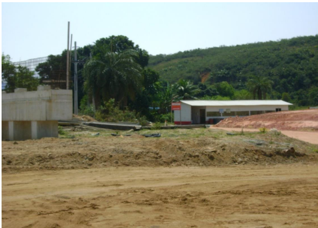
Figura 32: Canteiro de obras do Arco Metropolitano
