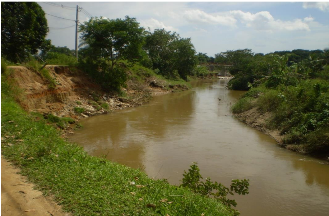
Figura 31: Obra do Arco Metropolitano ao fundo e margem de acesso às casas
