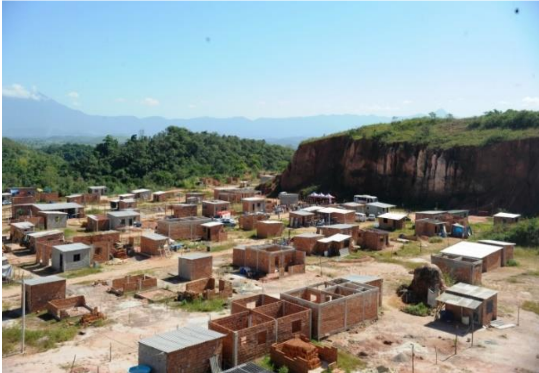
Figura 20: Ocupação na área da barreira em Cidade Meninos - limite com bairro Santa Isabel
