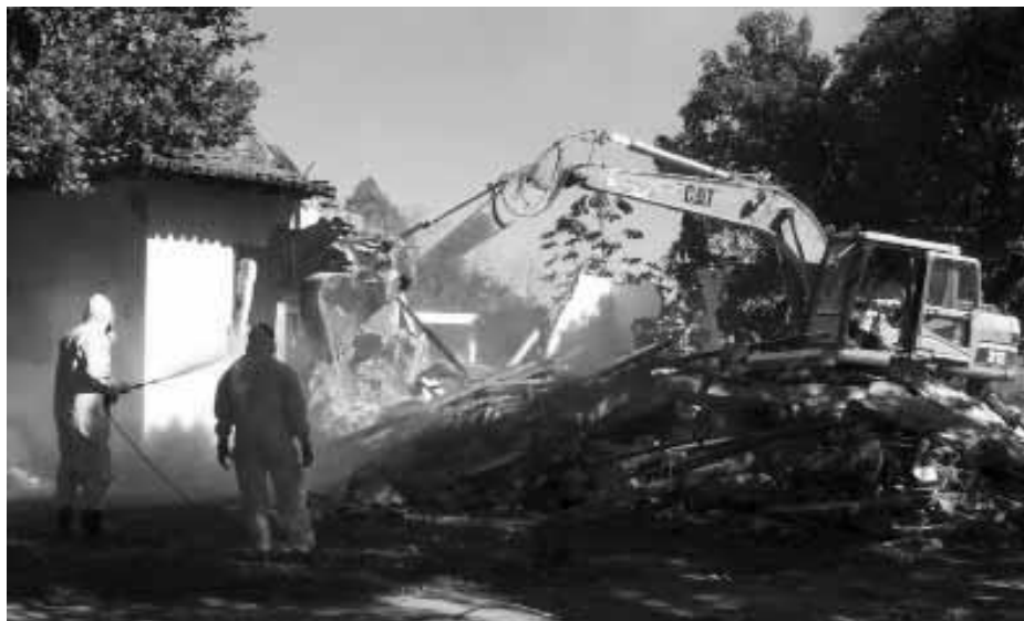
Figura 17: Demolição de imóveis dentro da área cercada do foco principal
