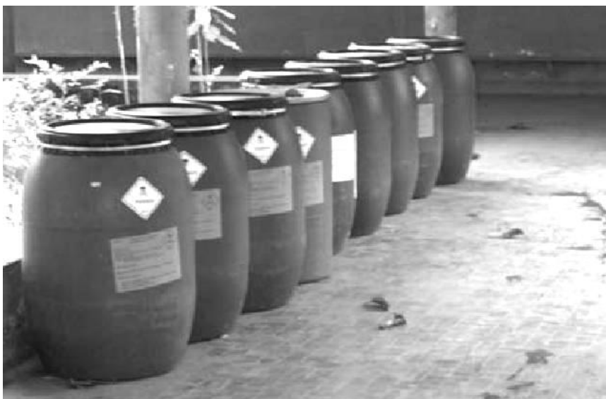
Foto 14 – Bombonas para armazenamento de HCH. Essas foram utilizadas para transportar cerca de 40 toneladas para serem incineradas na Reduc. As bombonas da antiga fábrica, segundo os moradores, eram de papelão e, com o passar dos anos se romperam. Fonte: MS, 2002.
