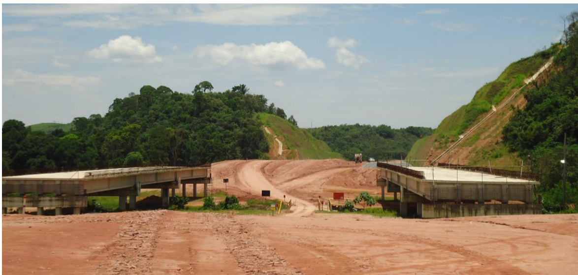
Foto 32 – Obras do Arco Metropolitano. Foto: Neiva Vieira da Cunha.
