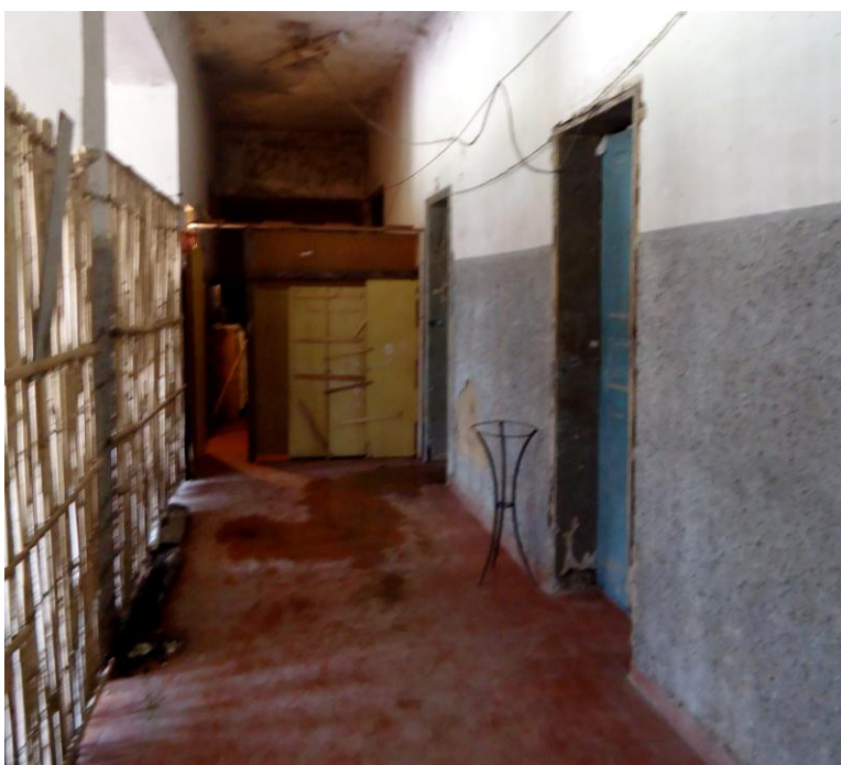
Foto 25 – Parte interna do IPGV. Atenção pra as três moradias de familias diferentes, cada uma ocupando uma sala dessa parte da antiga escola. Foto: Neiva Vieira da Cunha.
