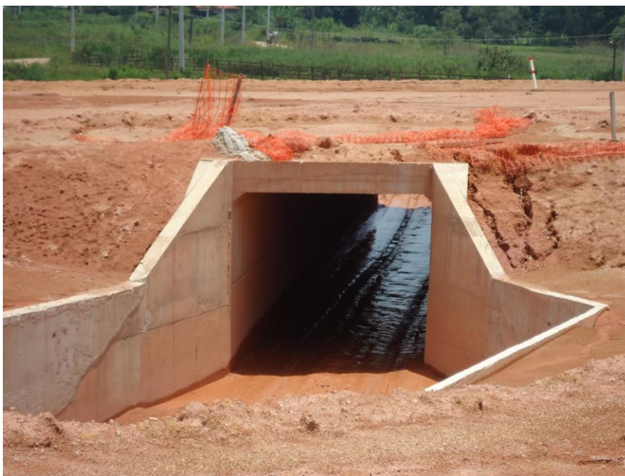
Foto 33 – Imagem da passagem que os técnicos que orientam as obras do Arco Metropolitano mandaram abrir para a passagem do gado.
