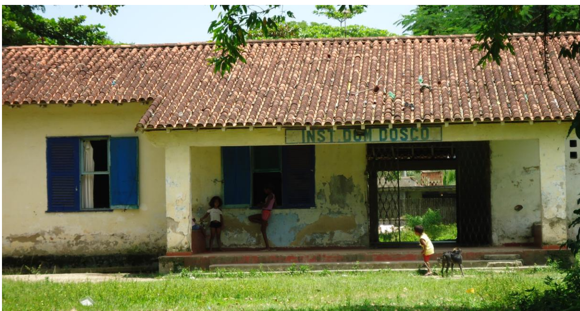
Foto 8 – Retrato atual do Instituto Dom Bosco. No interior do prédio, cada antiga sala de aula é uma casa de família. Foto: Neiva Vieira da Cunha.
