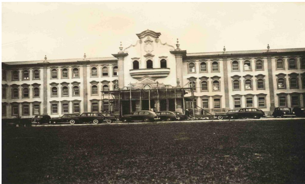
Figura 3. Fachada do Prédio Central (P1) 1967
