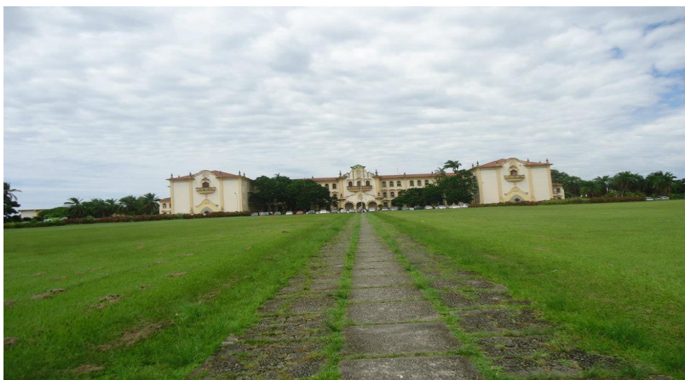
Figura 4. Fachada do Prédio Central (P1) 2013
