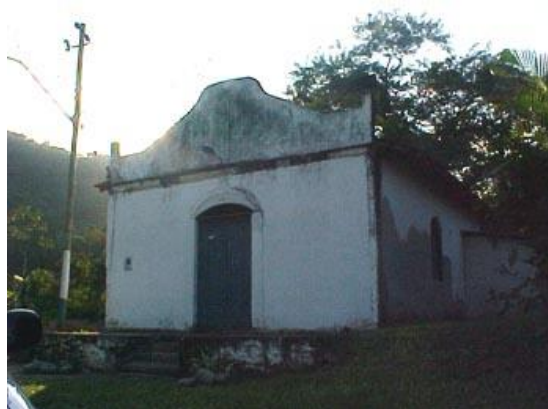
Figura 2 - Capela de Santa Rita do Bracuí
