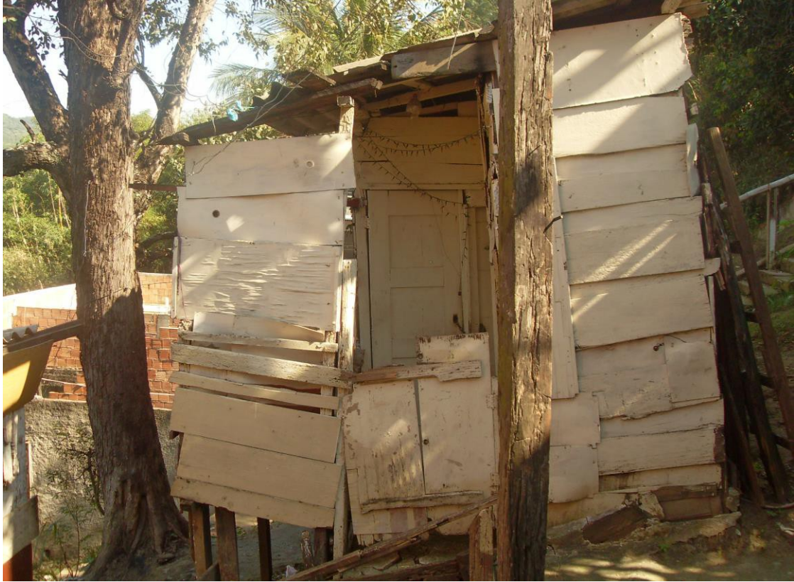
Fotografia 4 – Casas na região do Caboclo – Parque Candelária
