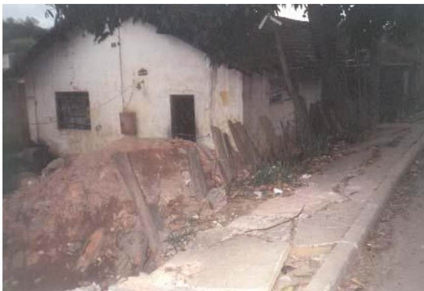
Figura 11 Casa do Colono da Estação Fitossanitária
