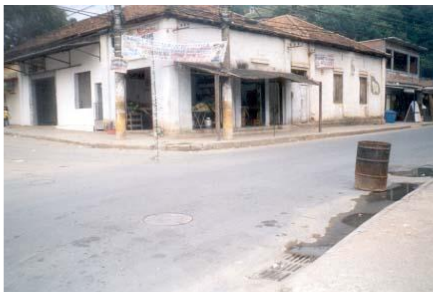
Figura 14 I Cooperativa Entrada Parque Comercial
