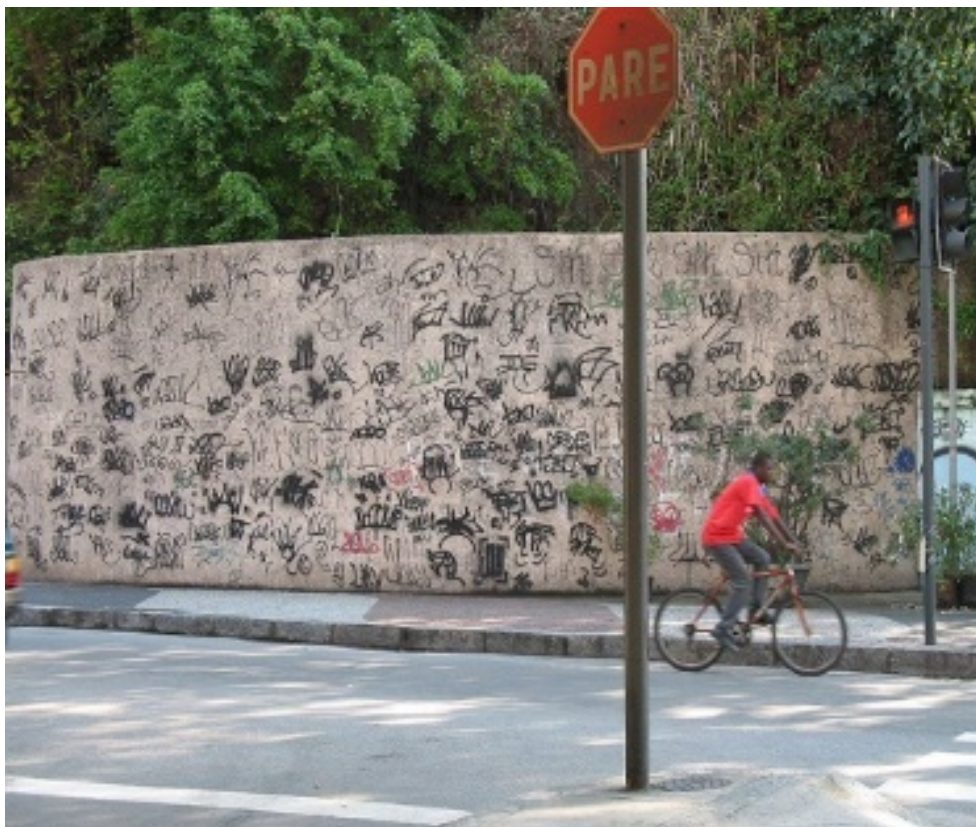
Figura 26: muro apagado em Laranjeiras.
