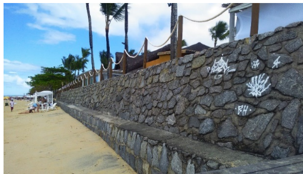
Figura 9: muro de um resort na praia de Trancoso (Bahia).
