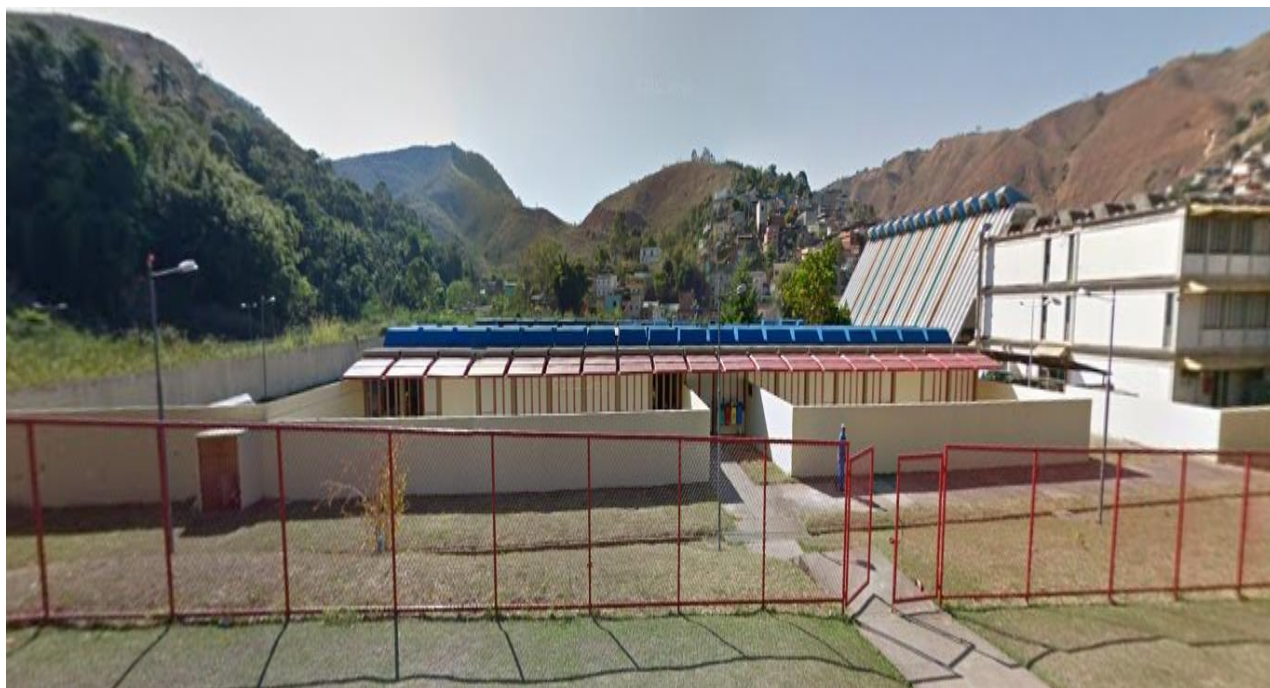
Figura 1 – Vista frontal da Creche Ubuntu.
