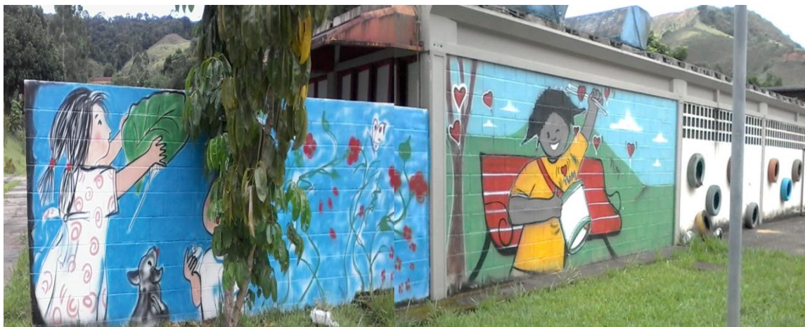
Figura 15: Lateral direita da creche revitalizada.
