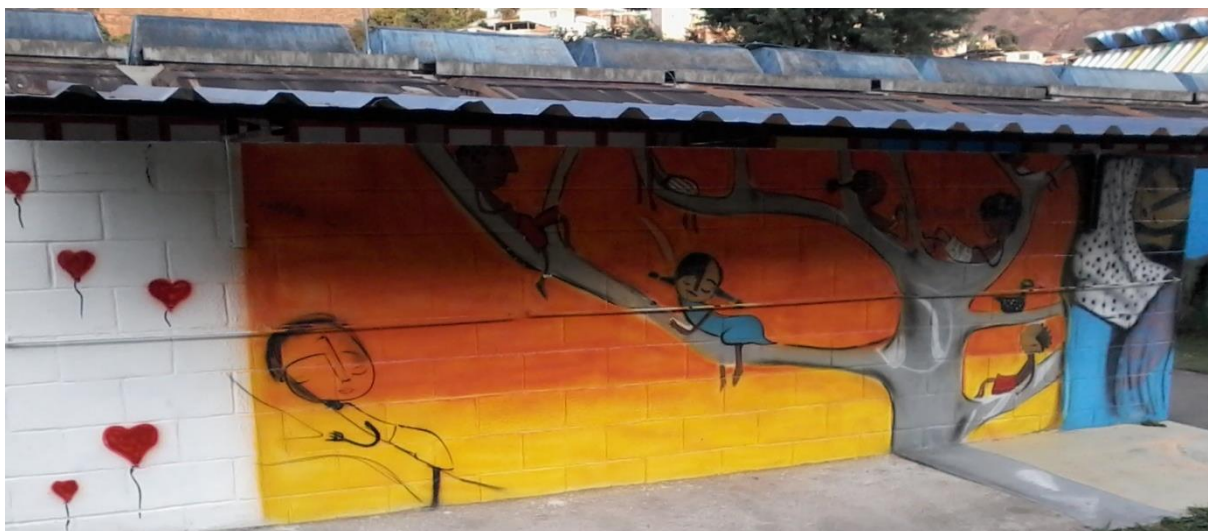
Figura 12 – continuidade da lateral esquerda do muro em 2016.
