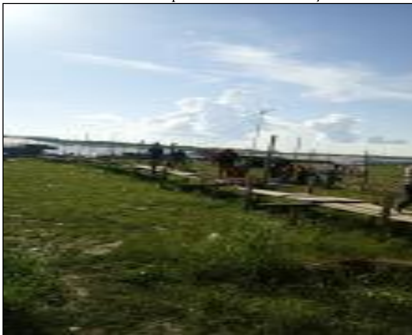
Foto 3 - Ponte de madeira para acesso à embarcação fluvial
