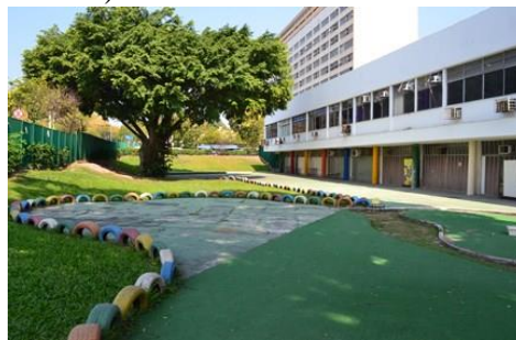
Figura 17 – Vista parcial das instalações da EEI-UFRJ (prédio do IPPMG).
