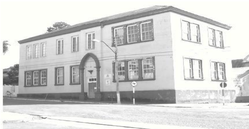
Figura 42 - Edifício do AA de São Luiz das Missões. Fonte: BRASIL. RMAIC, 1926.
