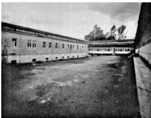
Figura 11 - Pátio Interno Gymnásio Mineiro (1890-1912).
