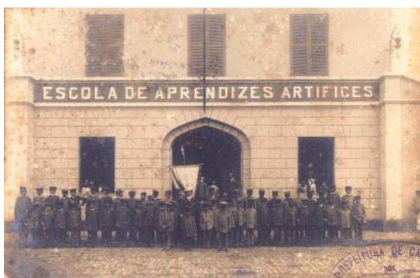
Figura 14 - Escola de Aprendizes Artífices - Campos de Goytacazes, RJ, Prédio da Estação Ferroviária 97
