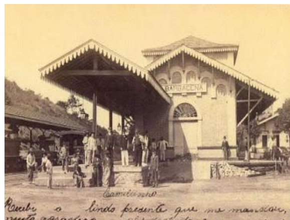
Figura 27 - Estação Ferroviária de Barbacena (s/d).
