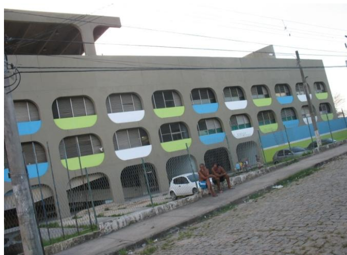
Fotografia 3 - CIEP – S. João de Meriti. Obra externa concluída. Fonte: O autor, 2010.
