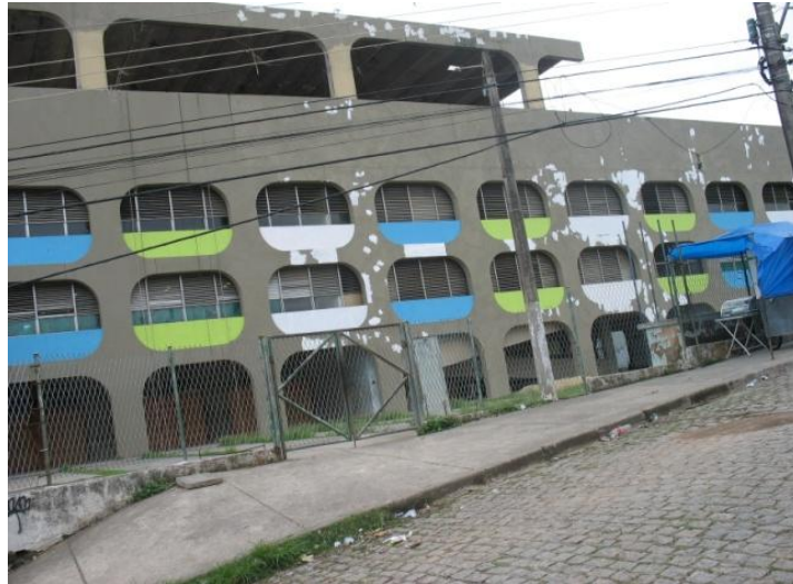
Fotografia 2 - CIEP – S. João de Meriti. Obra de recuperação do prédio em curso. Foto: O autor, 2010
