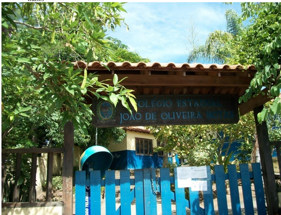
Figura 19: Fachada do Colégio João de Oliveira Botas – Antiga Escola Praiana de Armação dos Búzios – Armação dos Búzios
