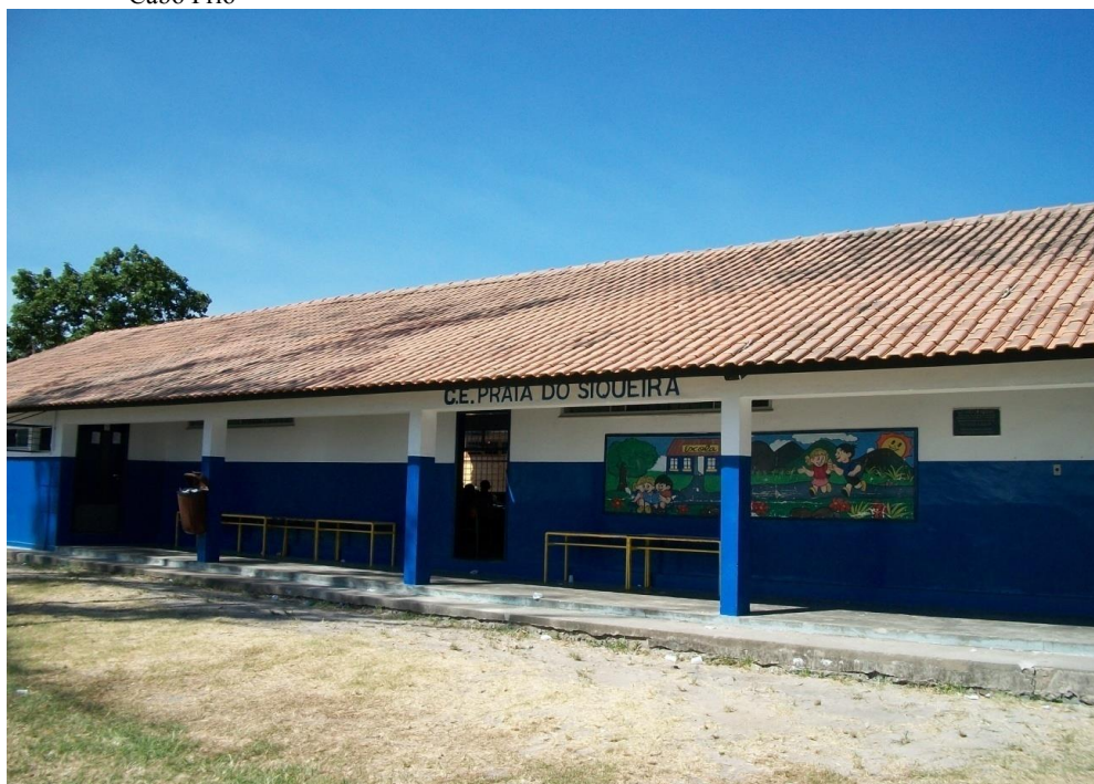
Figura 21: Fachada do Colégio Estadual Praia do Siqueira - Antiga Escola Praiana Praia do Siqueira – Cabo Frio
