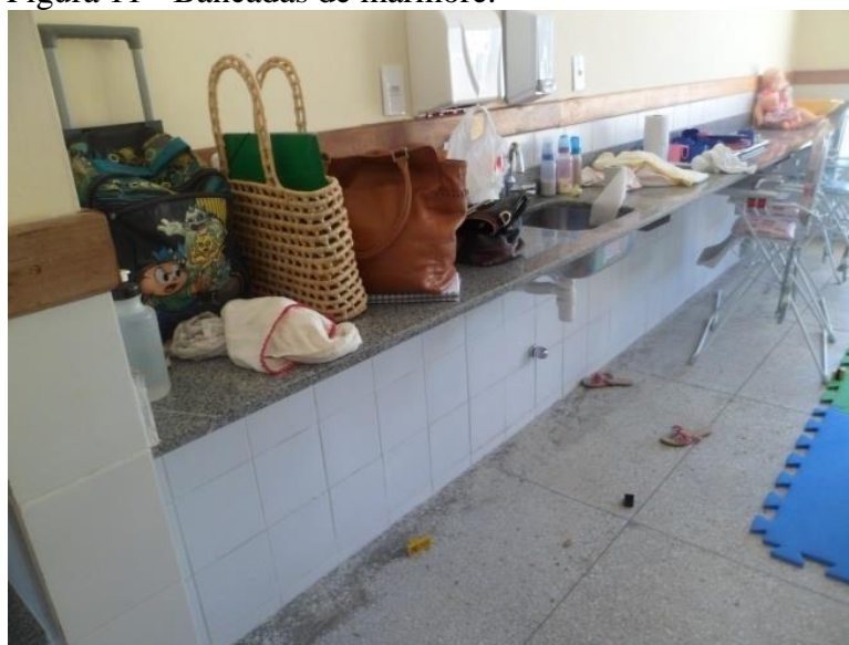
Figura 11 - Bancadas de mármore.
