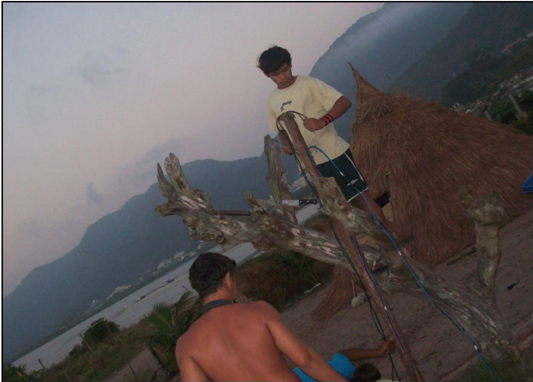
Figura 02. Construção da nova escola após incêndio, Ti Camboinhas, Niterói (RJ).
