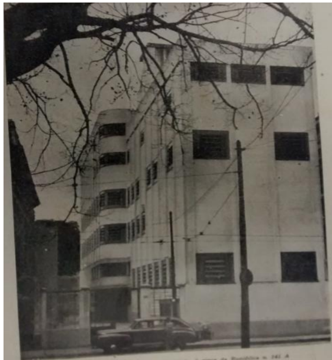
Figura 2 - Fotografia prédio de funcionamento do INCE em 1944
