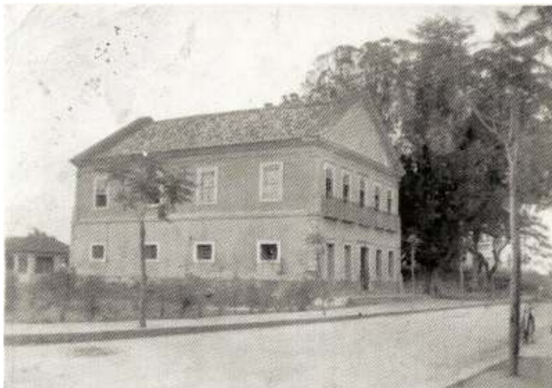
Fig.3: Prédio de 1841 que abrigou a Câmara Municipal, a cadeia e hoje a Casa da Cultura Fonte: Acervo da Secretaria Municipal de Turismo de Maricá – sem indicação de data
