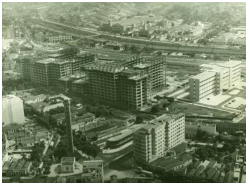
Fotografia 5-Campus da UERJ em construção, anos 70. Fonte: http://www.rioquepassou.com.br/2006/09/11/construcao-do-campus-da-uerj-anos-70/
