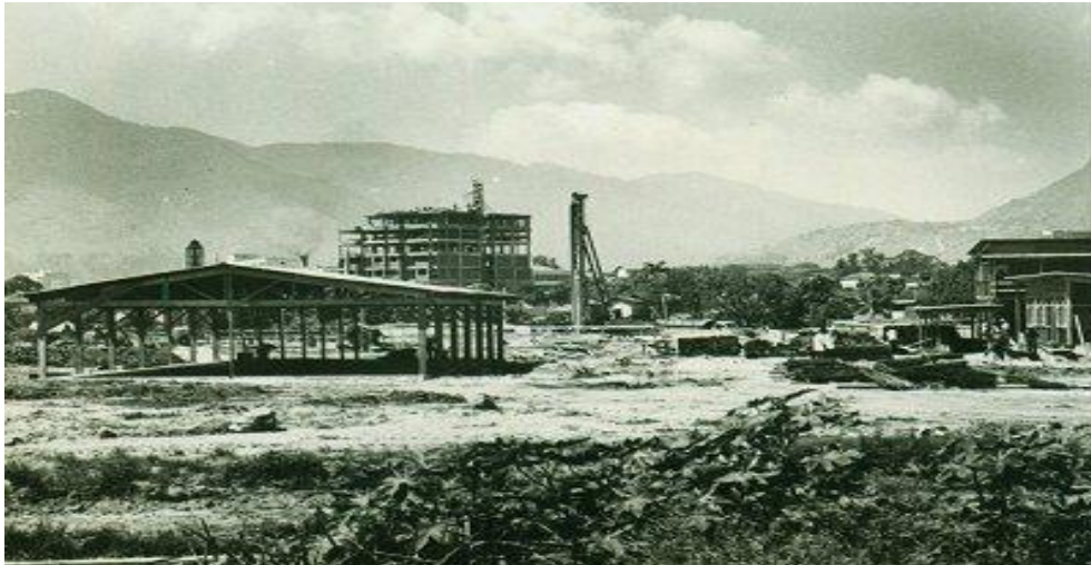
Fotografia 4-Canteiro de obras do Campus Uni Francisco Negrão de Lima, da UERJ, 1960. Fonte: Acervo do Núcleo de Memória, Informação e Documentação (MID) da UERJ
