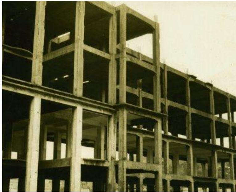
Fotografia 3- estrutura de concreto armado abandonada, conhecida popularmente como "esqueleto", foi erguida para ser um hospital público e até os anos 60 permaneceu inacabada. Foi transformada no Pavilhão Haroldo Lisboa da Cunha, um dos prédios do Campus Universitário Francisco Negrão de Lima, da Universidade do Estado da Guanabara (UEG). Década de 1960.
