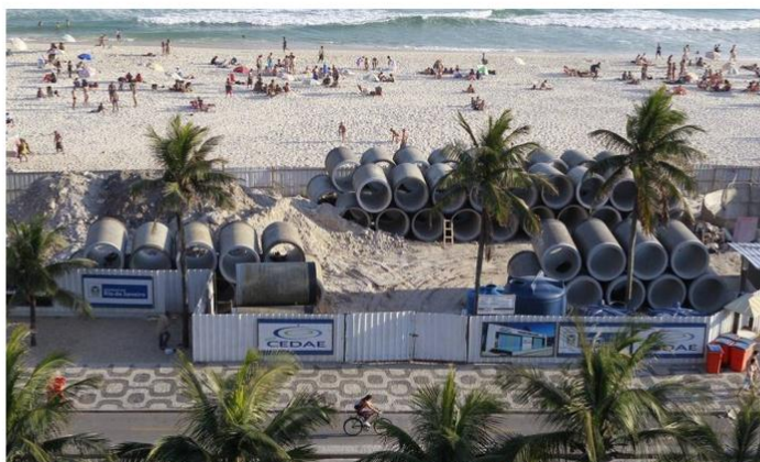
Tapume das obras de instalação de tubulações da Cedaé: transtornos - Márcio Alves / Agência O Globo
