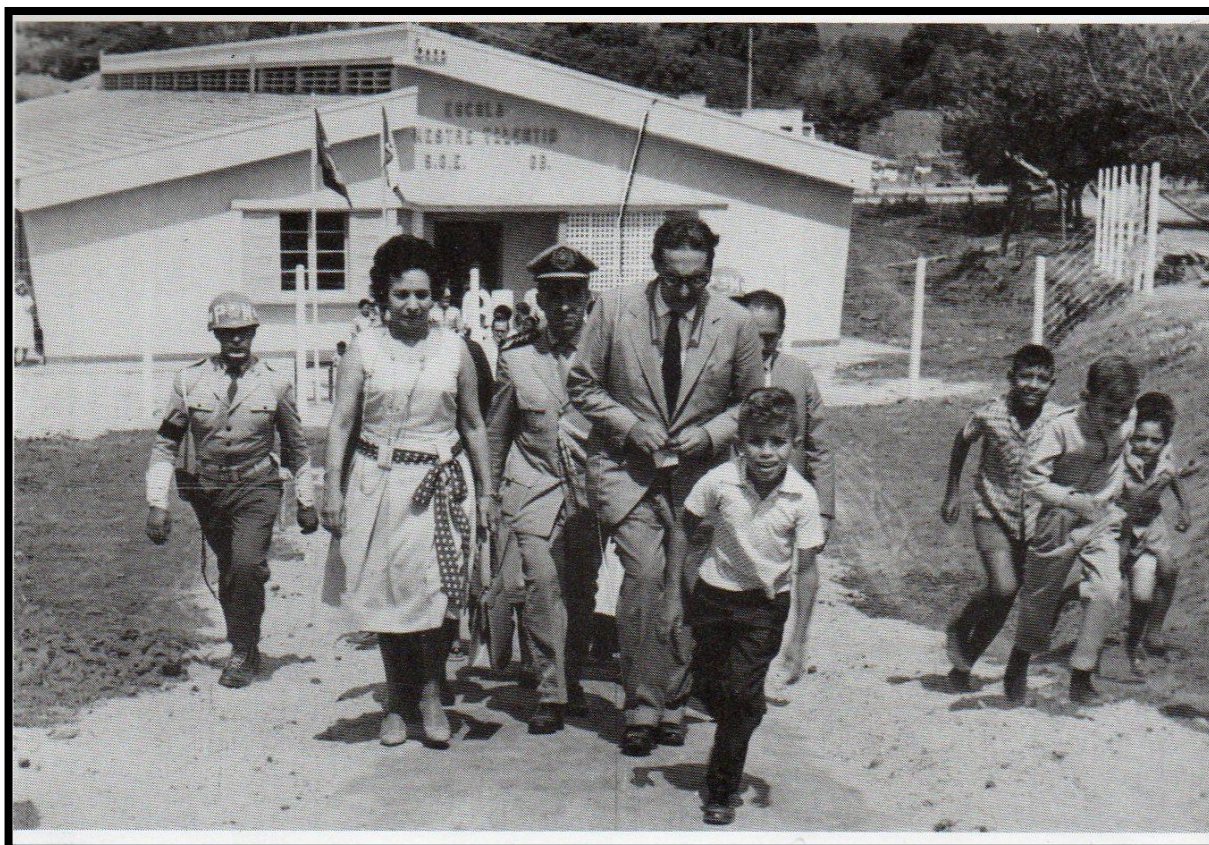
Figura 12 - Inauguração da Escola Mestre Valentim, localizada na rua Jornalista Mário Lisboa, 127, no bairro de Anchieta, em 03 de outubro de 1962.
