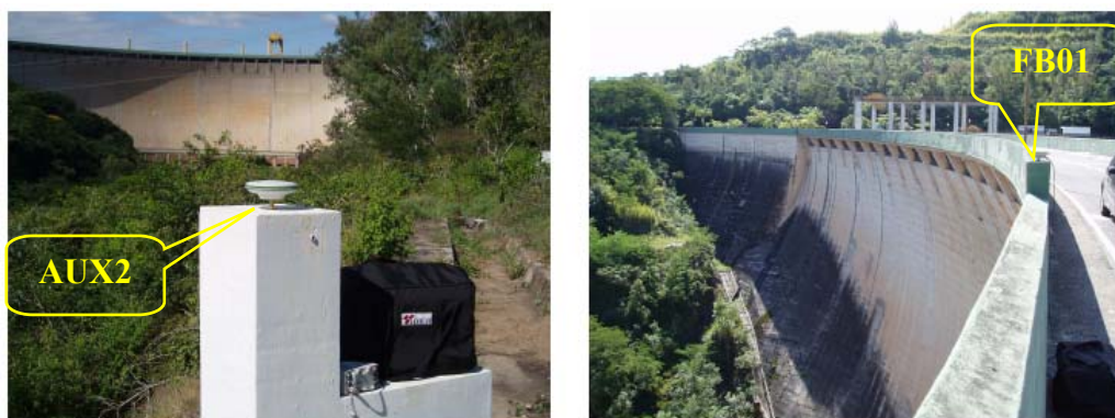
Figura 15 – Pilar (AUX2) implantado para compor a estrutura geodésica de controle da barragem de Funil e pilar para rastreio junto à barragem (FB01).
