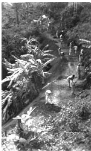
Figuras 13: Estrada da Colônia – Manutenção feita por presidiários
