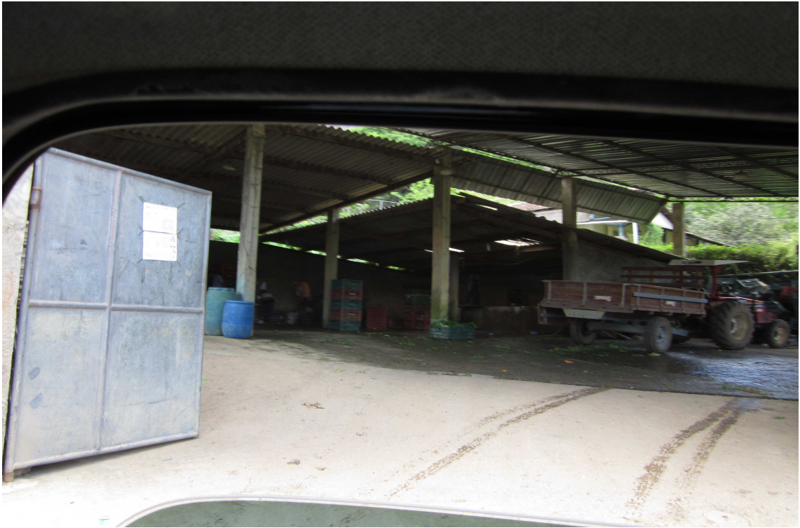
Figura 14 – Parte média da bacia – galpão de cooperativa.
