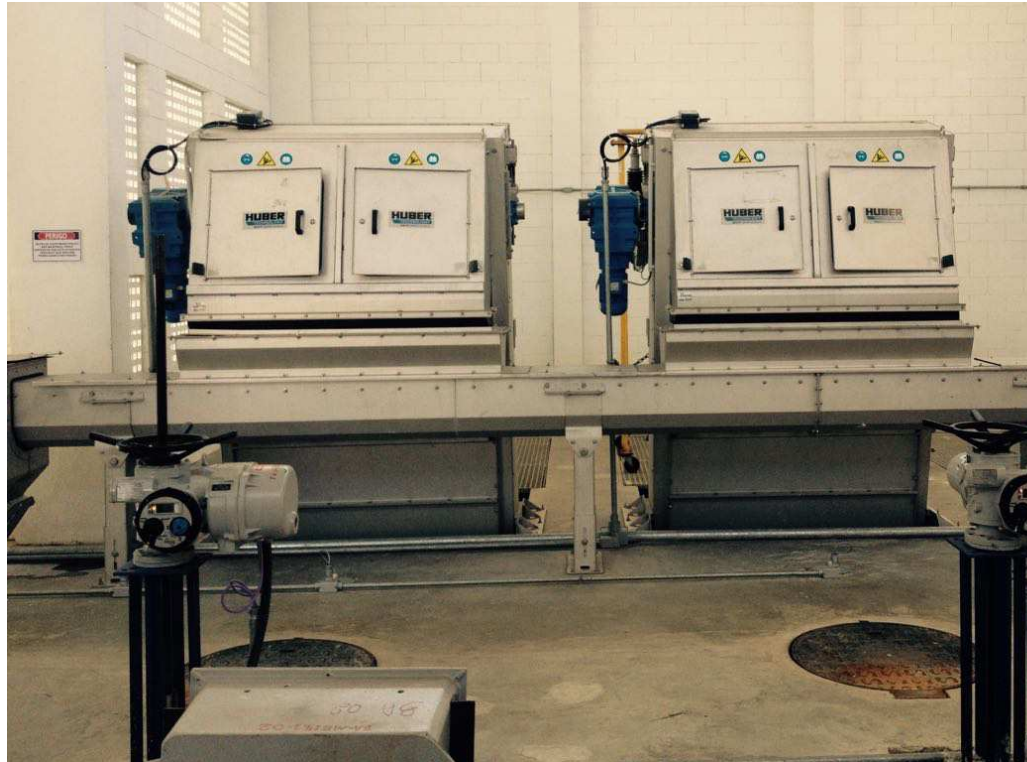
Figura 16 - Gradeamento mecanizado.
