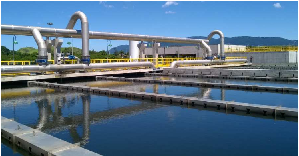
Figura 22 - Reator biológico em fase de alimentação/descarte simultâneos.
