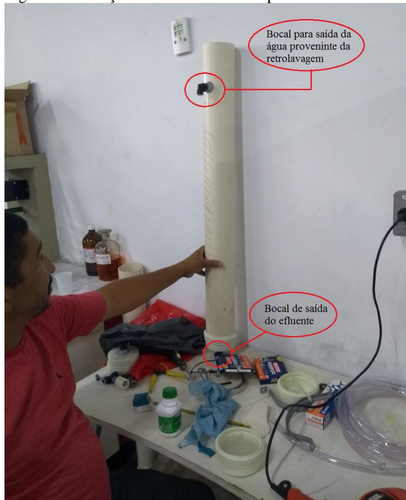
Figura 14 - Fixação do filtro terciário na parede
