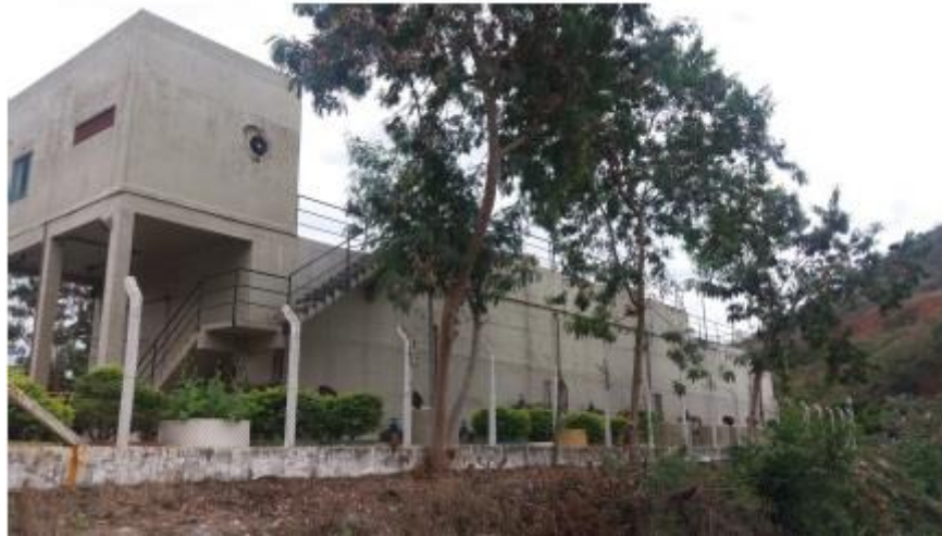
Figura 8 - Vista geral da ETE Sapucaia do Rio
