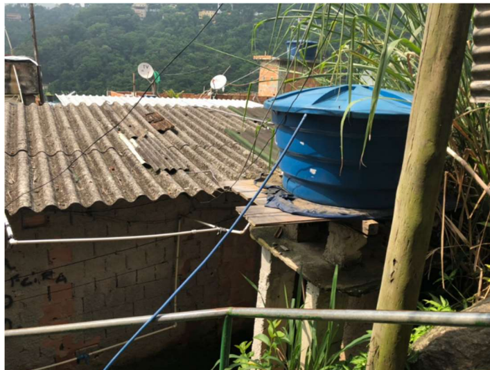
Figura 25 – Abastecimento de água de uma residência com mangueira.
