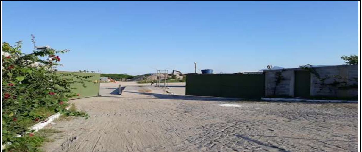
Figura 27 – Entrada da Usina de Beneficiamento de RCD
