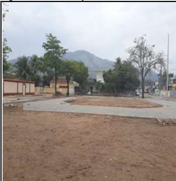
Figura 35 – Pavimentação do Piso
