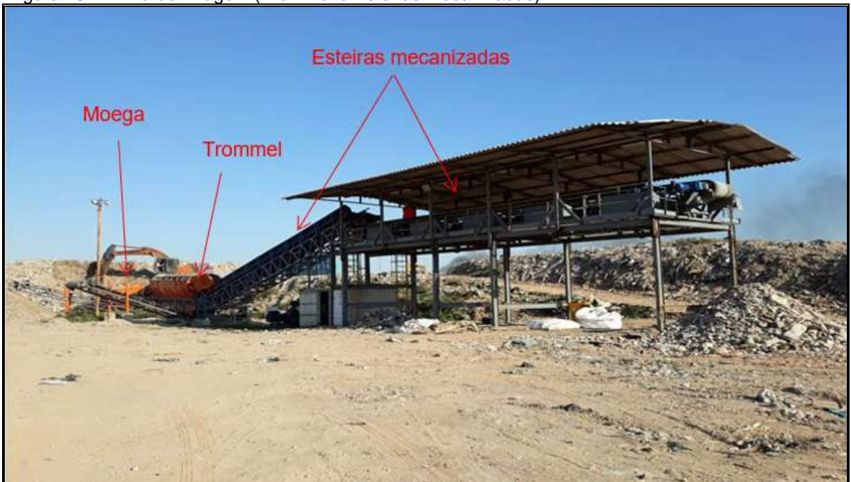
Figura 28 – Linha de Triagem (Trommel e Esteiras Mecanizadas)
