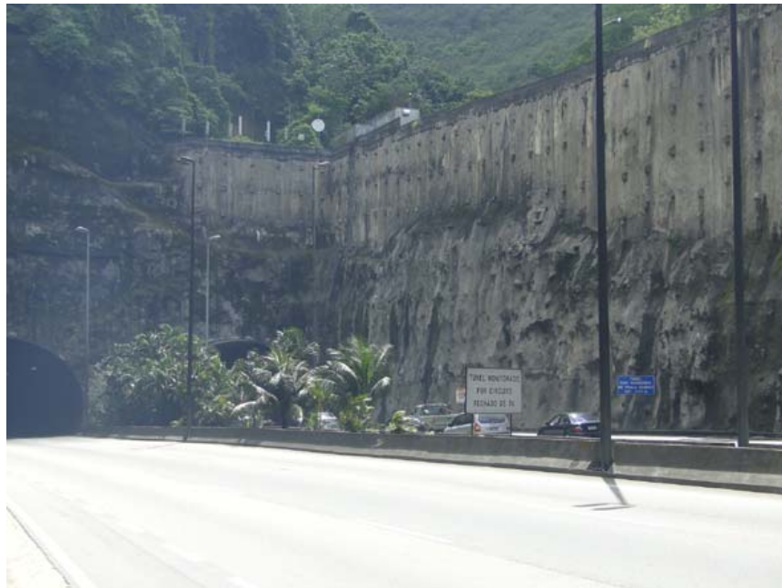
Figura 19 - Túnel engenheiro Raymundo de Paula Soares – Emboque (saída)
