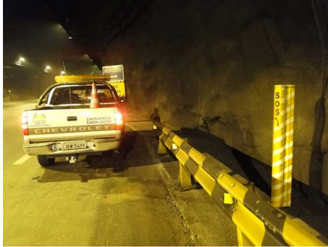
Figura 18 - Túnel Engenheiro Raymundo de Paula Soares - call-boxes
