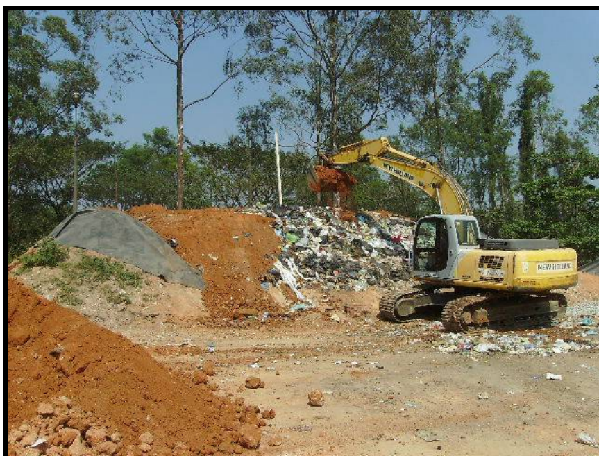
Figura 21 – Operação com a retro-escavadeira
