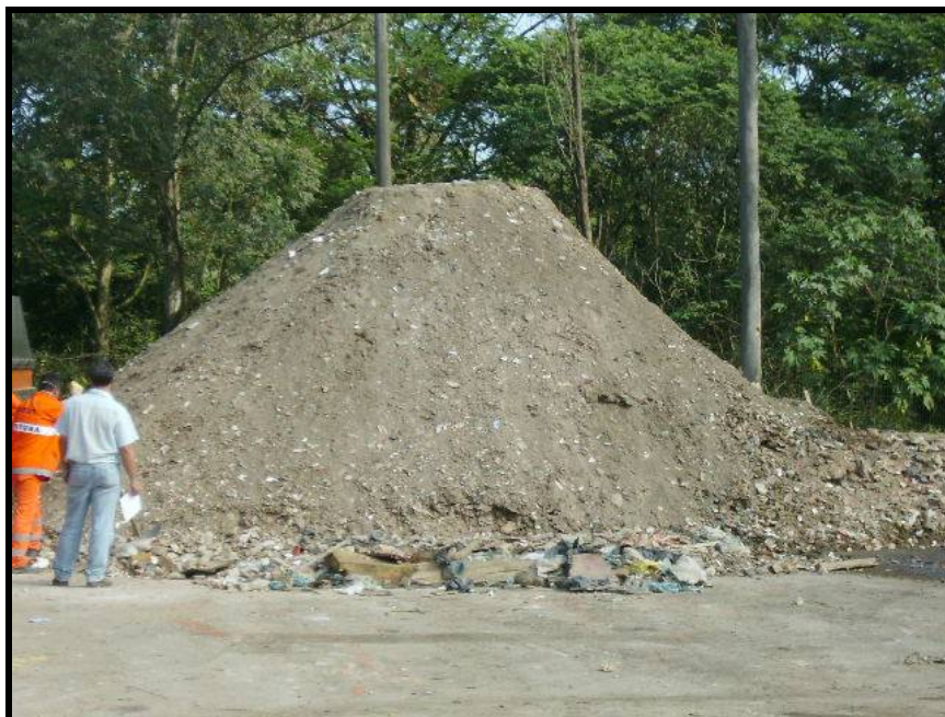
Figura 9 – Formação do talude e das bermas
