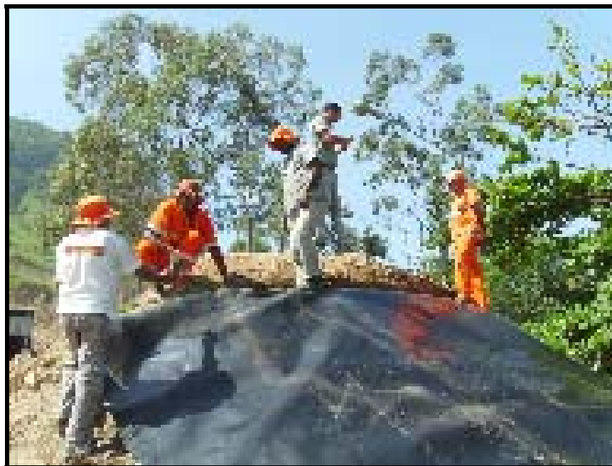
Figura 31 – Ancoramento da manta com a argila
