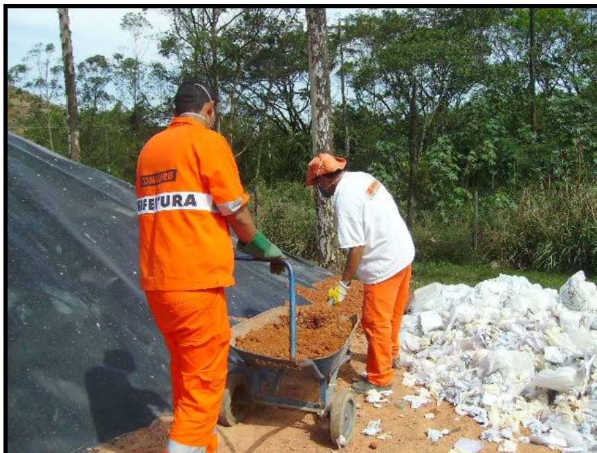
Figura 22 – Colocação de argila nas laterais da célula
