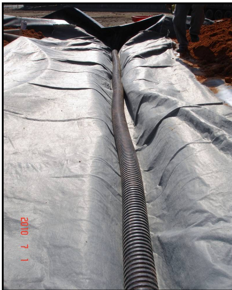
Figura 15 – Valeta para drenagem com tubo “canaflex” revestida por BIDIM
