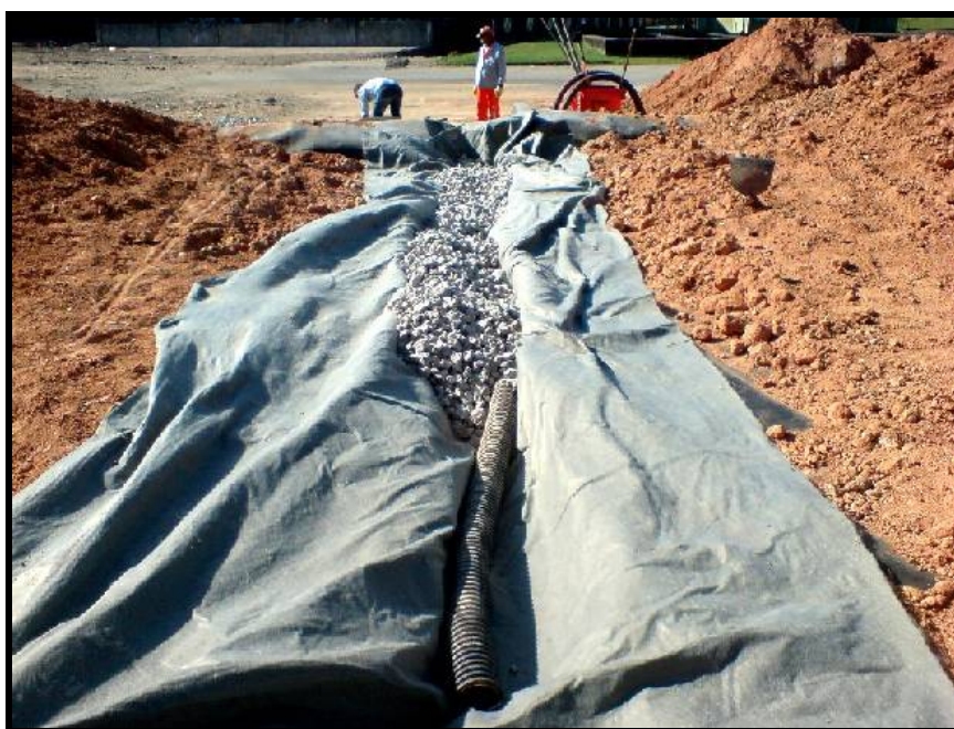
Figura 17 – Finalização das valetas com depósito das britas
