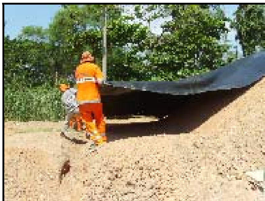
Figura 30 – Estiramento da manta sobre a superfície das células
