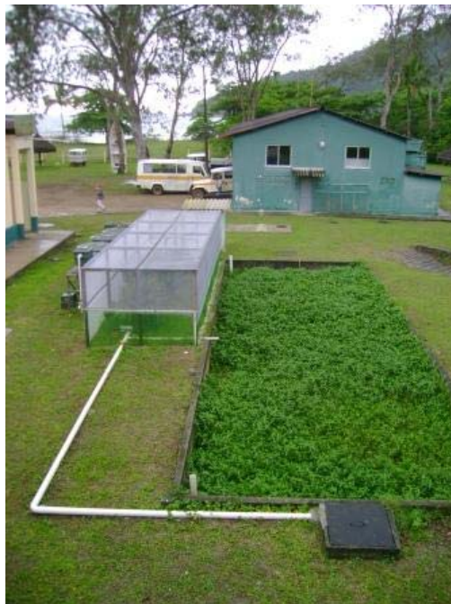
Figura 14 - Vista do Ecossistema Engenheirado e wetland constru do do sistema de tratamento original (Foto: A.L.S. Salom o).
