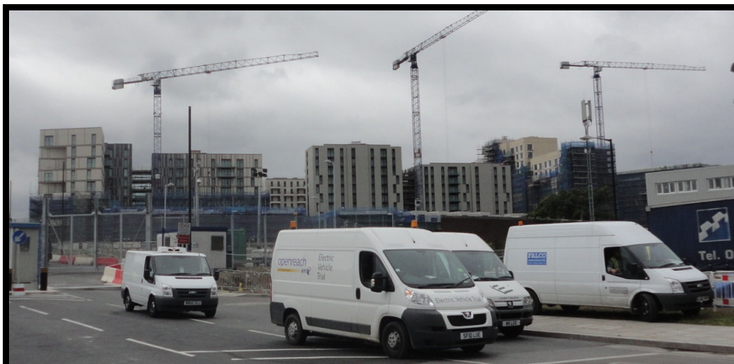
Figura 12 – Vila Olímpica em fase final de construção Fonte: Propria
