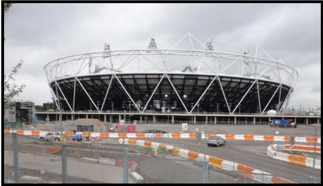
Figura 9 – Estádio Olímpico em fase final de construção.
