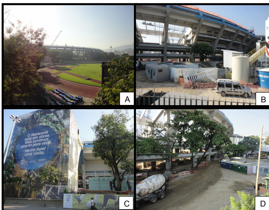
Figura 25 (A), (B), (C) e (D) - Complexo do Maracanã em fase de obras Fonte: Propria
