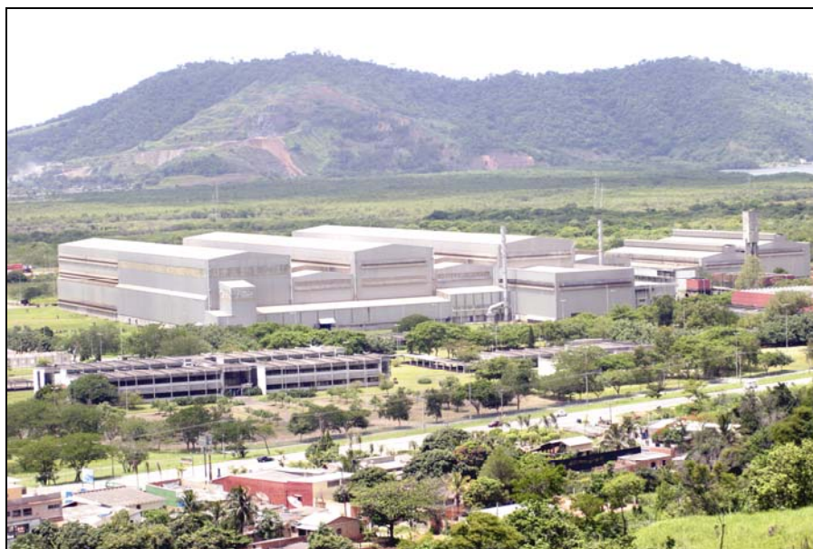
Figura 13: vista frontal da empresa
