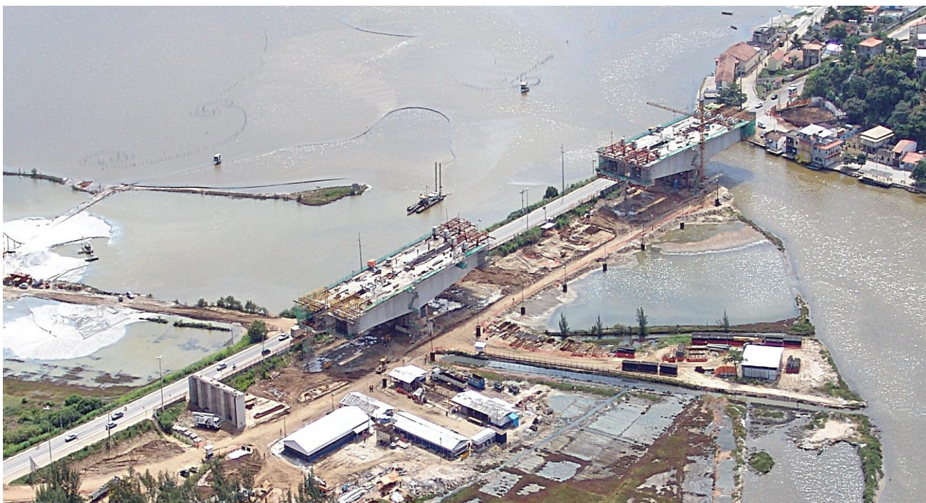
Figura 32- Obras de dragagem no canal da laguna de Araruama. Fonte: Garcia et al. , 2009
