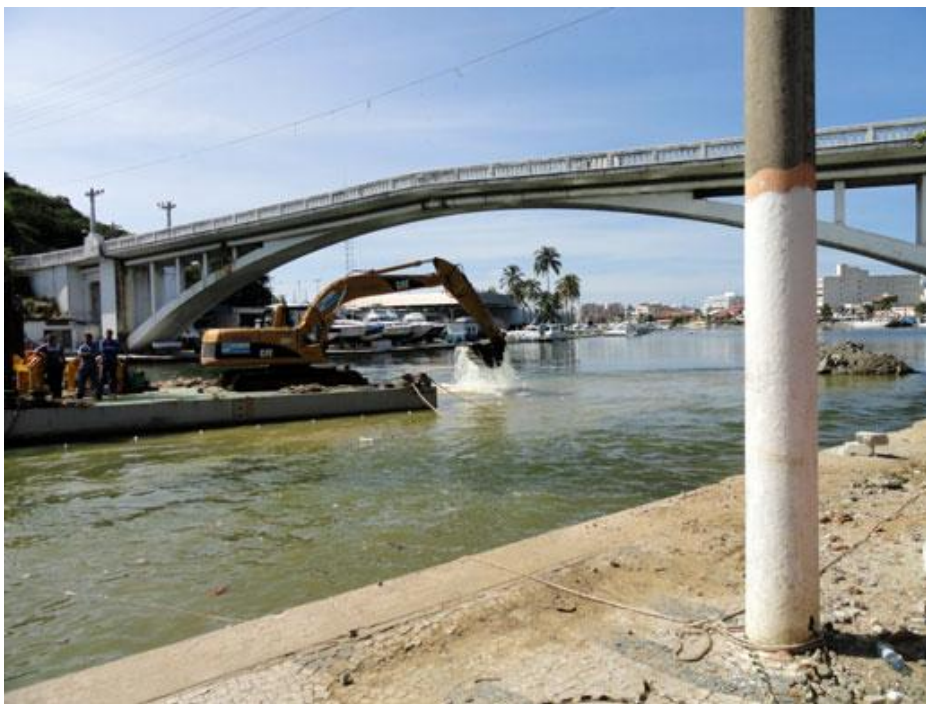
Figura 31- Máquina que trabalha no derrocamento entre a Ponte Feliciano Sodré e a Ponte Wilson Mendes, em Cabo Frio. Fonte: http://www.bigpop.com.br/site/index.php/meio-ambiente/recomeca-a-dragagem-na-lagoa-araruama/
