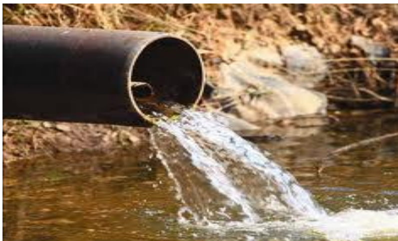
Figura 7- Lançamento de efluentes em corpos hídricos
