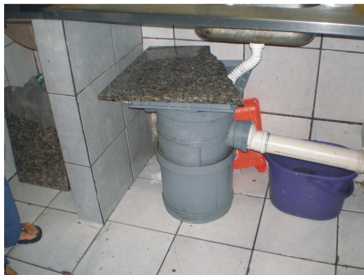
Figura 16: Cantina Bloco C (5º Pavimento) (Detalhe da caixa de gordura)
