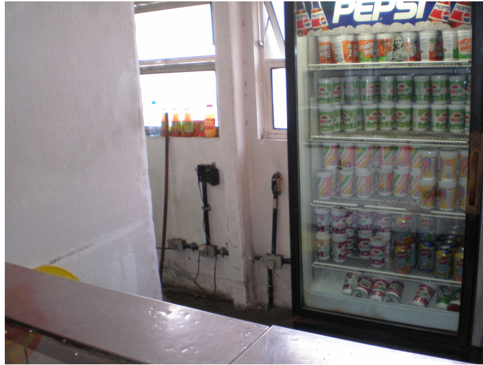
Figura 21: Cantina Bloco C (12º Pavimento) (Detalhe instalação elétrica)
