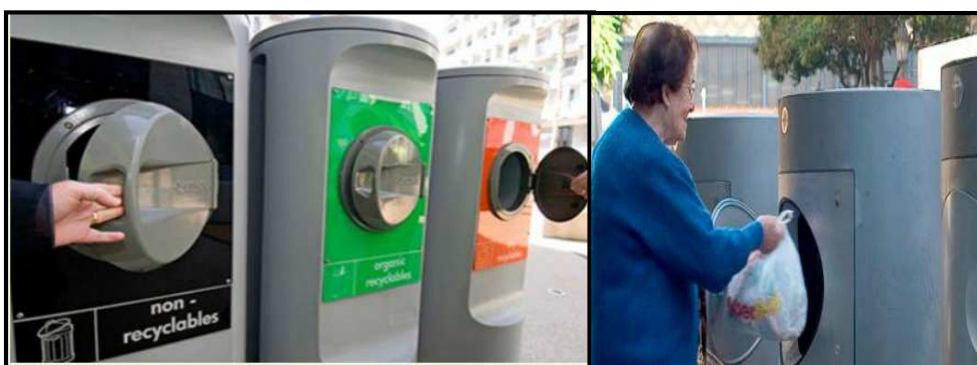
Figura 17: Lixeiras dispostas nas calçadas parte do sistema pneumático. Fonte: Ecodesenvolvimento, 2012.
