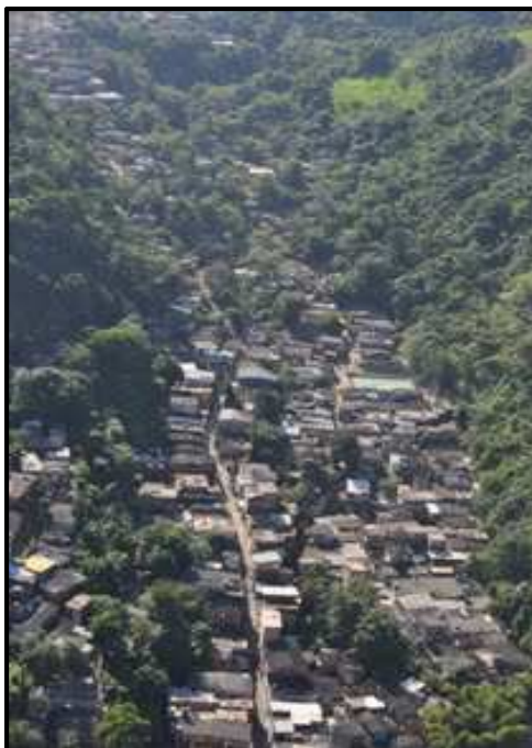
Figura 21: Ocupação irregular da encosta do morro do Bumba. Fonte: G1, 2012.
