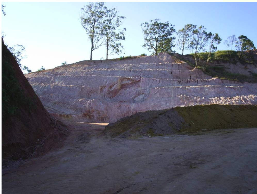
Figura 20 - Entrada da principal área do aterro sanitário municipal, onde serão construídas as células de resíduos sólidos urbanos.
