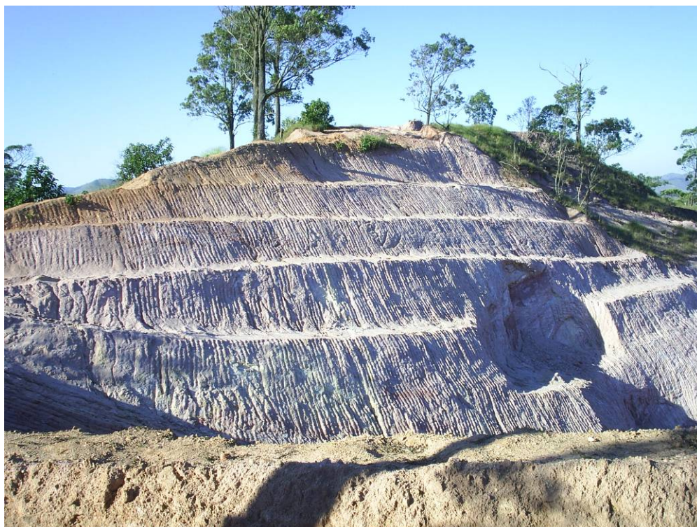
Figura 23 - Vista superior do talude lateral da principal área do aterro sanitário.
