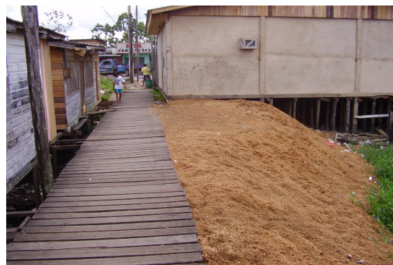
Figura 11. Foto dos fundos da bateadeira do Nivaldo, situada na Avenida Tancredo Neves, no Centro Comercial, onde são depositados os caroços de açaí. Detalhe para a montanha de caroços, dispostas na área de várzea, abaixo das palafitas. Montanha com cerca de 3 metros de altura.
