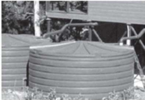
a) Cisterna em polietileno
