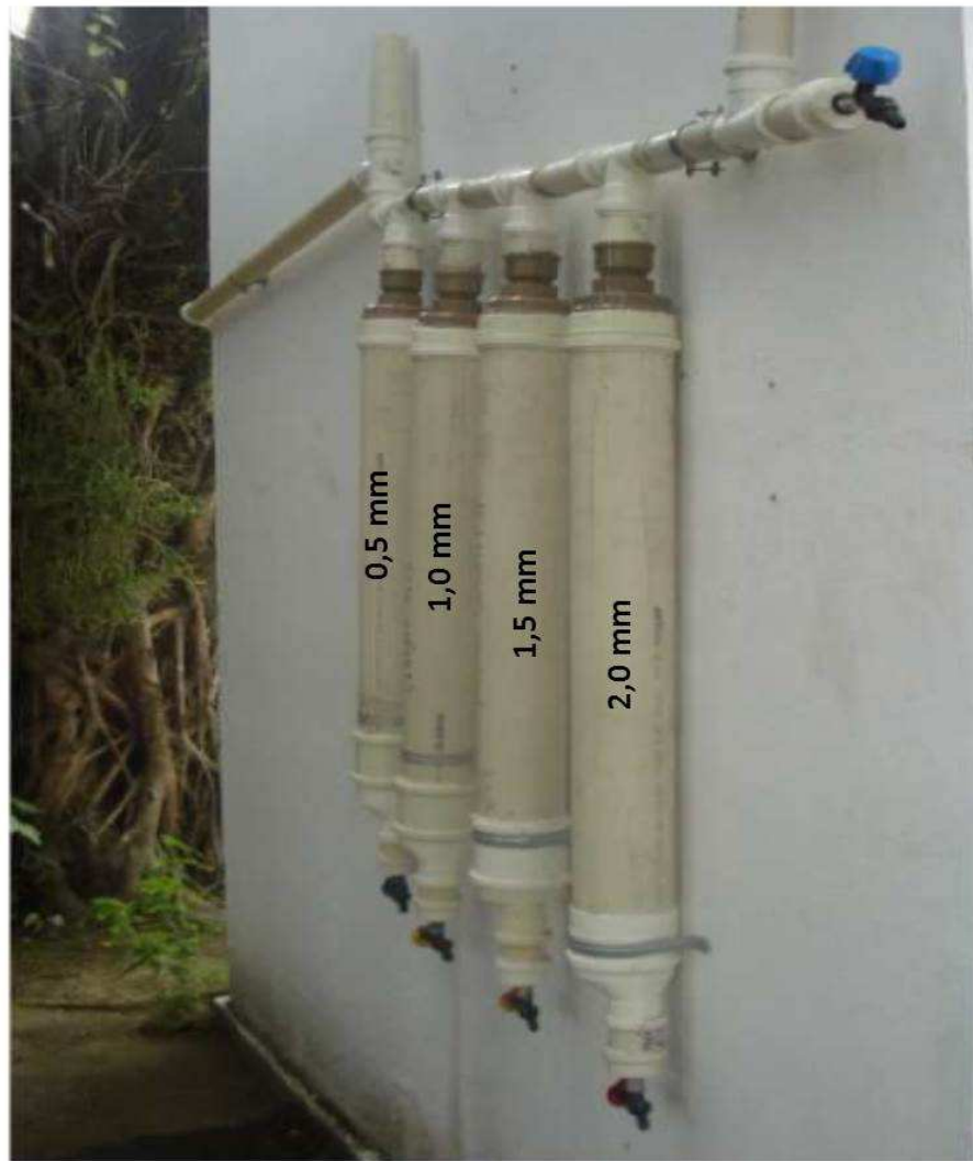
Figura 8: Coletor de Águas de Primeiro descarte, com diferentes volumes de descarte inicial. (Fonte: Peixe, 2012)
