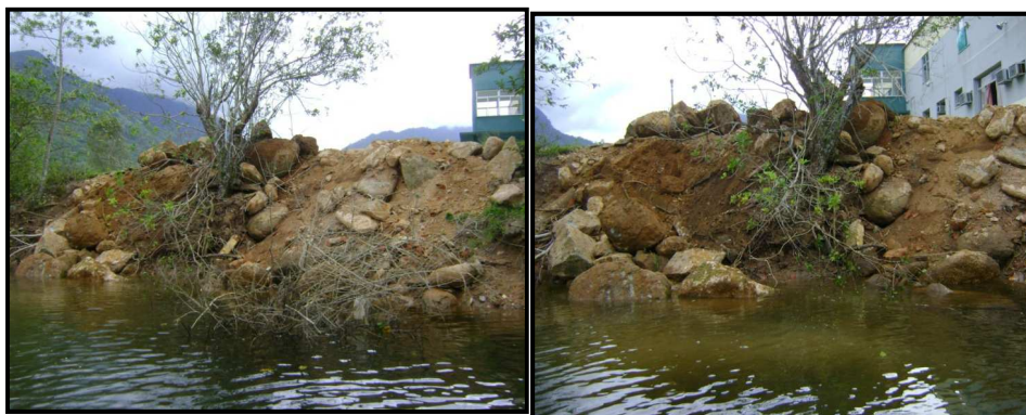
Figura 10 - Estação AN-02 – Erosão no leito do Córrego Andorinhas.
