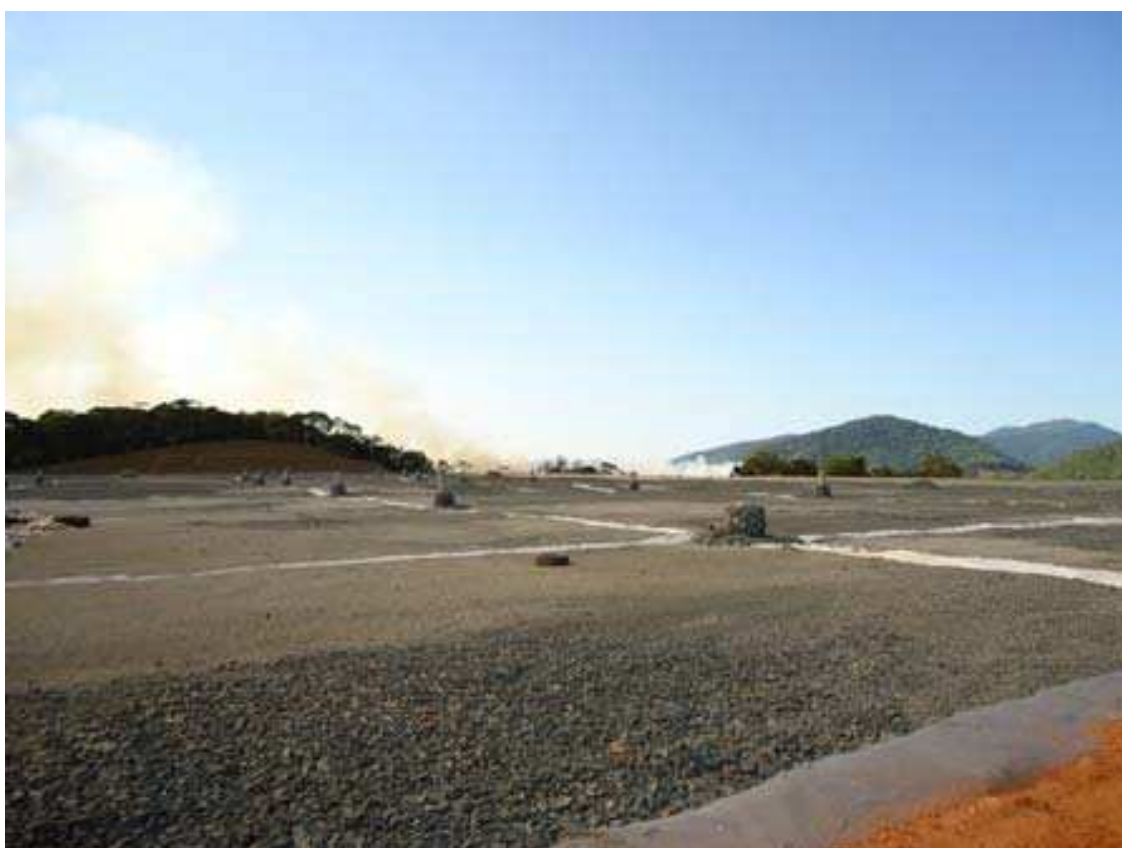
Figura 26: Dreno de gases.
