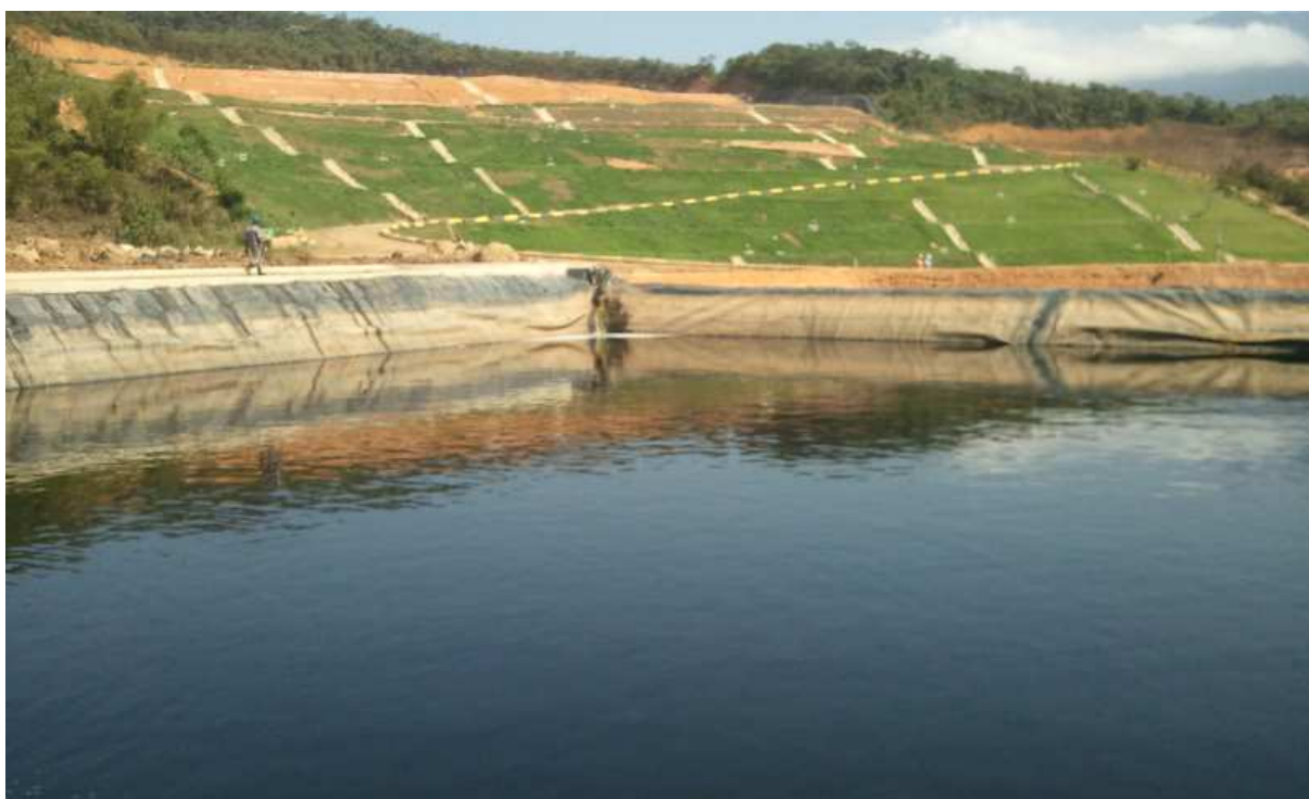
Figura 15: Lagoa de acumulação de lixiviados - CTR Nova Iguaçu. Fonte: Própria.
