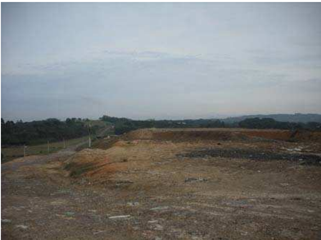
Figura 39: Vista geral do aterro.
