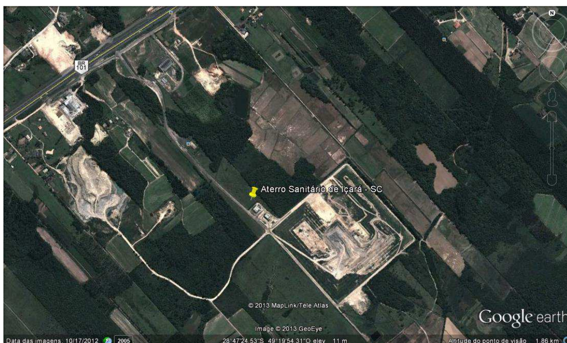
Figura 37: Aterro Sanitário de Içará.
