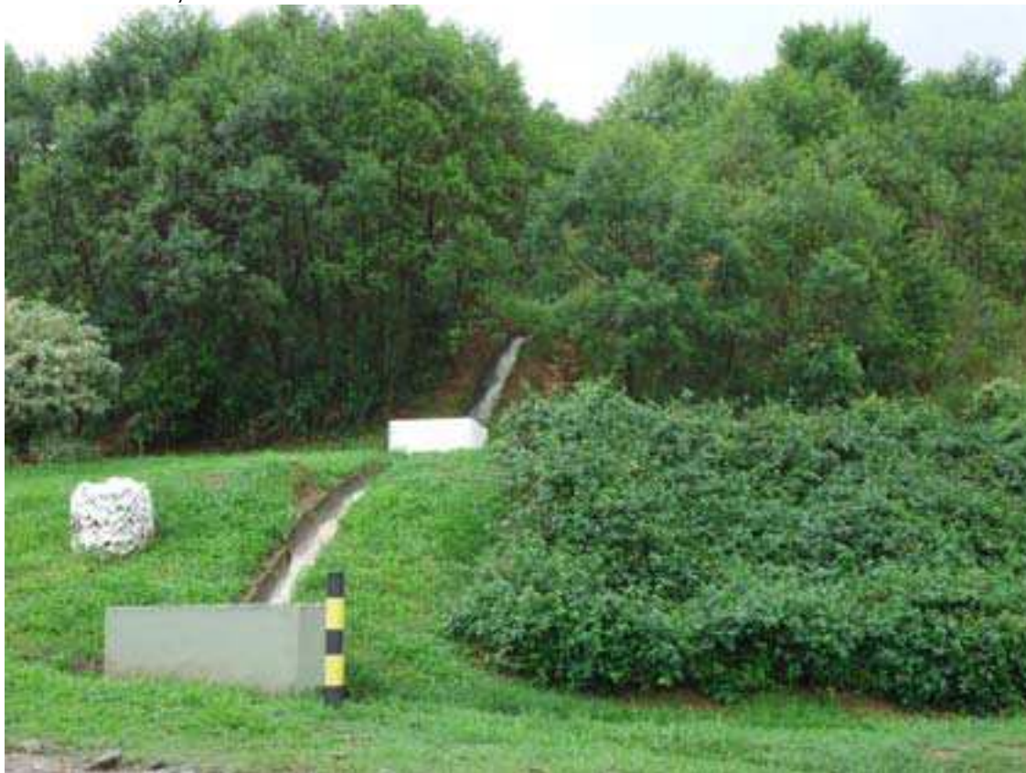
Figura 44: Drenagem de águas pluviais. Fonte: ABES-SC, 2012.
