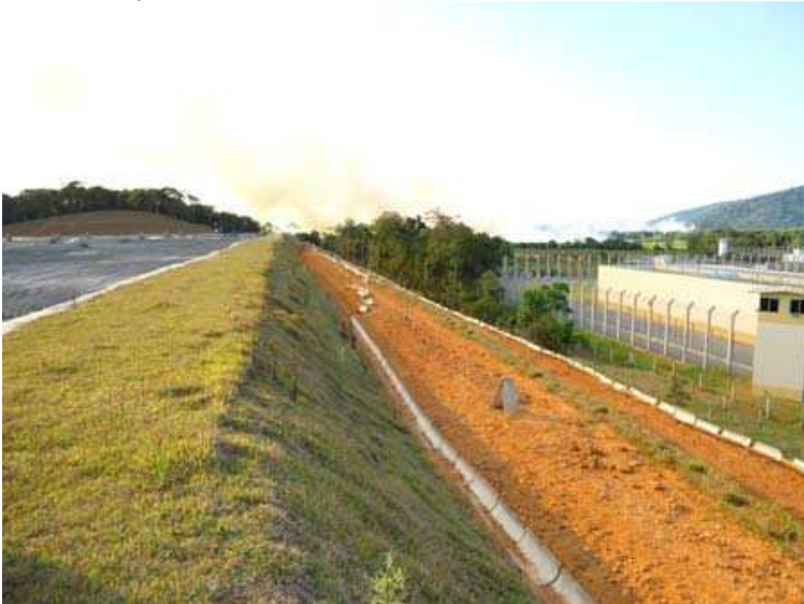
Figura 27: Drenagem de águas pluviais. Fonte: ABES-SC, 2012.
