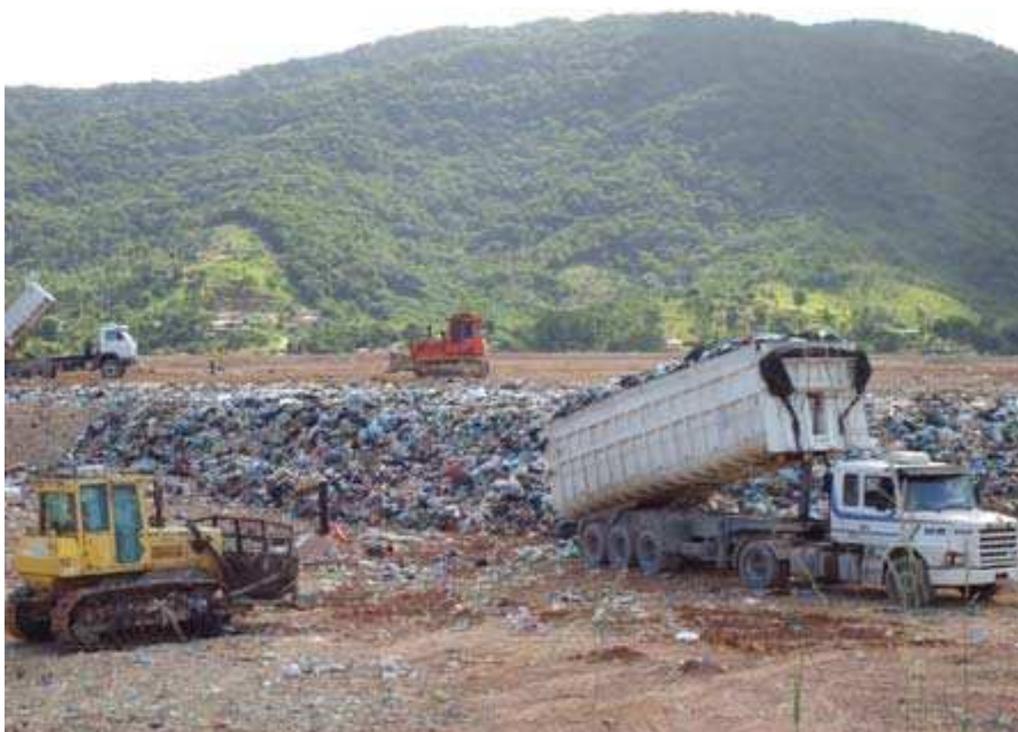
Figura 32: Outra vista da frente de operação.
