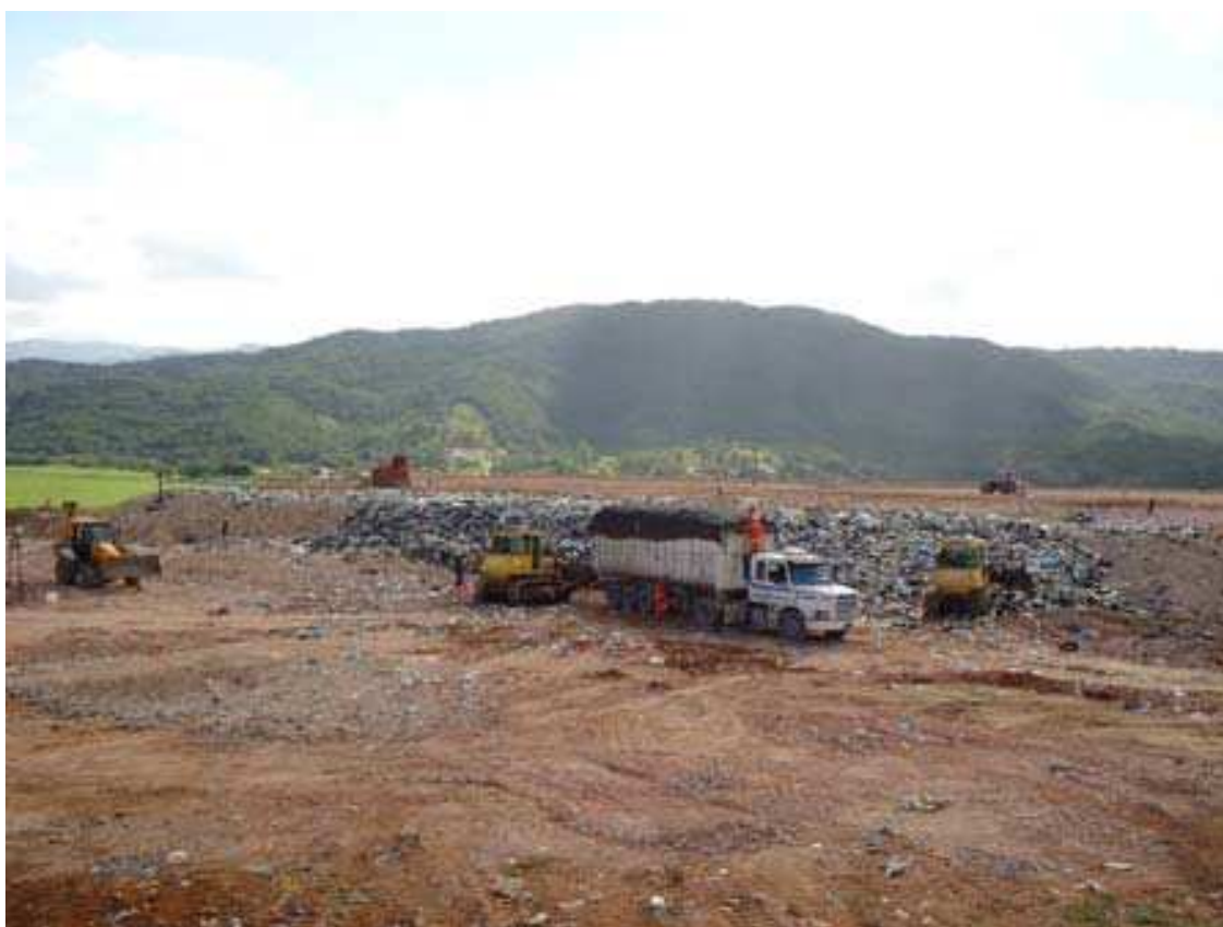
Figura 31: Frente de Operação do aterro. Fonte: ABES-SC, 2012.
