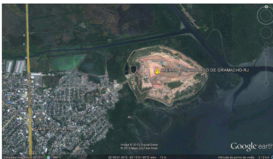
Figura 18: Localização do Aterro Controlado de Gramacho.
