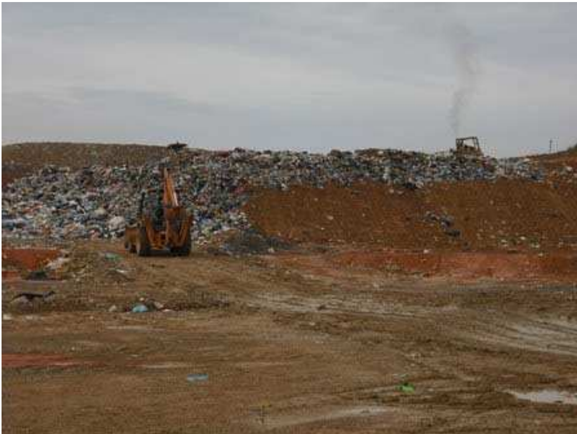
Figura 40: Frente de serviço. Fonte: ABES-SC, 2012.
