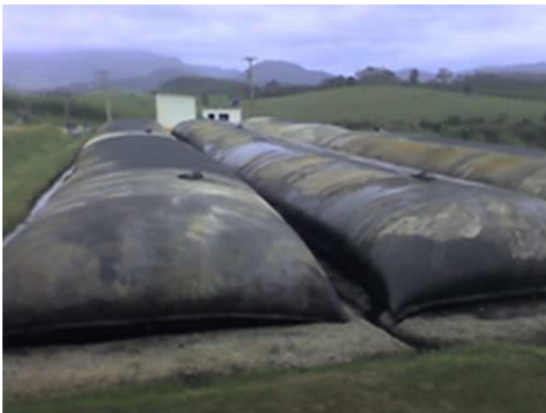
Figura 23: Geobags para tratamento do lixiviado bruto do aterro de Rio das Ostras. Fonte: http://mcparente.blogspot.com.br/2009/11/comissao-de-meio-ambiente-visita-aterro.html acessado em 02/03/2013.
