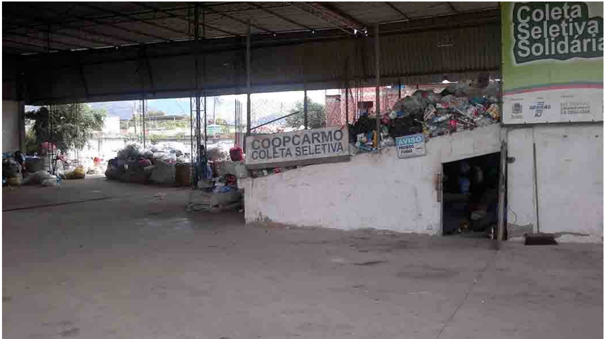
Figura 32 – Vista do interior do galpão, e a rampa, à direita.
