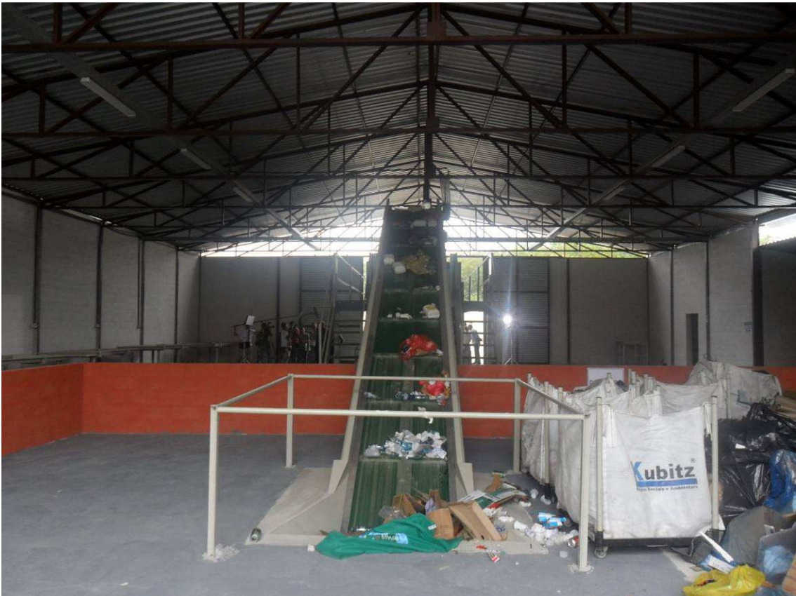
Figura 17: Maquinário no galpão do Polo de Reciclagem de Gramacho. fonte: a autora, 2013.
