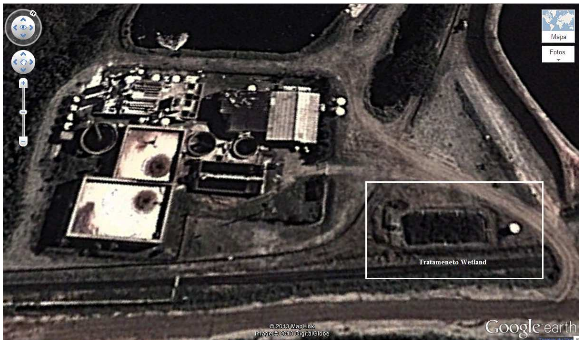
Figura 6 - Foto aérea da Estação de tratamento de Lixiviado do Aterro Controlado Metropolitano de Jardim Gramacho, em ênfase área de construção do wetland .
