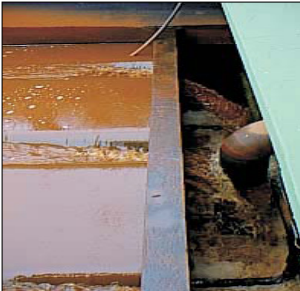
Figura 2.13 – Filtro sendo lavado. Fonte: Reali (1999).
