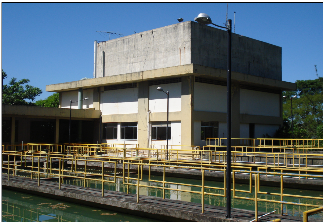
Figura 6.4 – Vista geral da ETA 1. Fonte: Arquivo do autor (2007).
