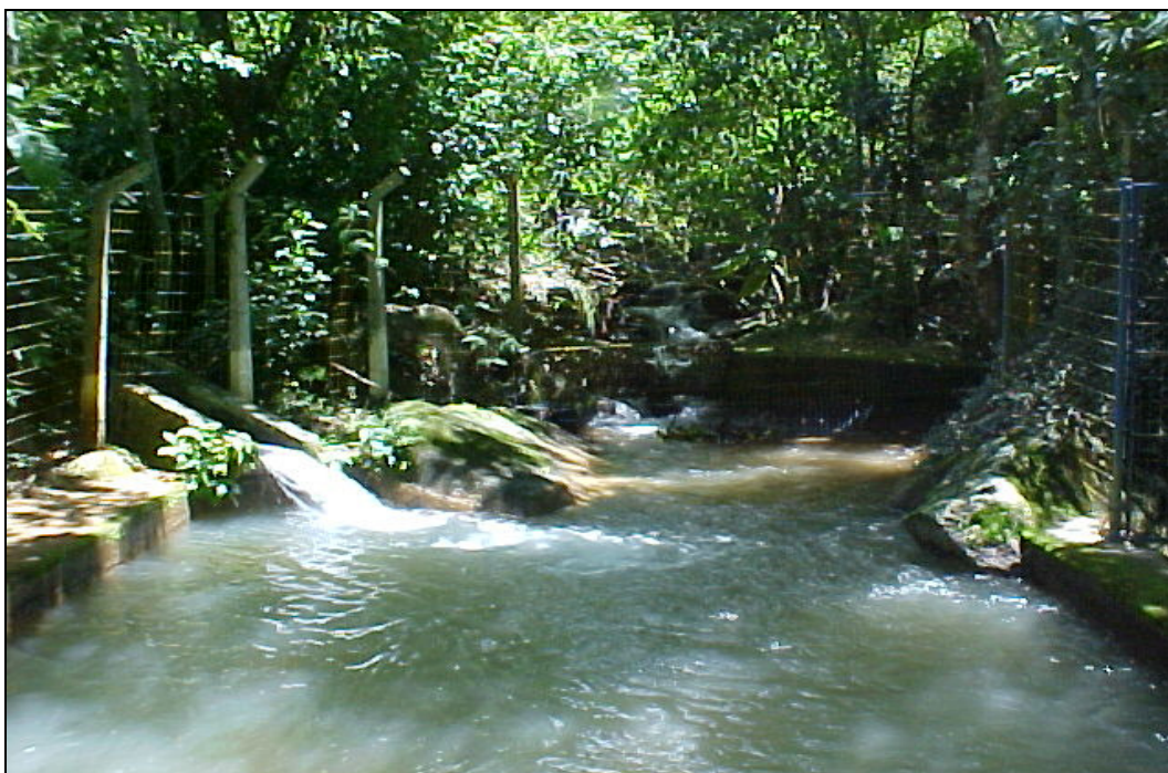
Figura 6.3 – Captação na Serra do Sambê. Fonte: Menezes (2006).
