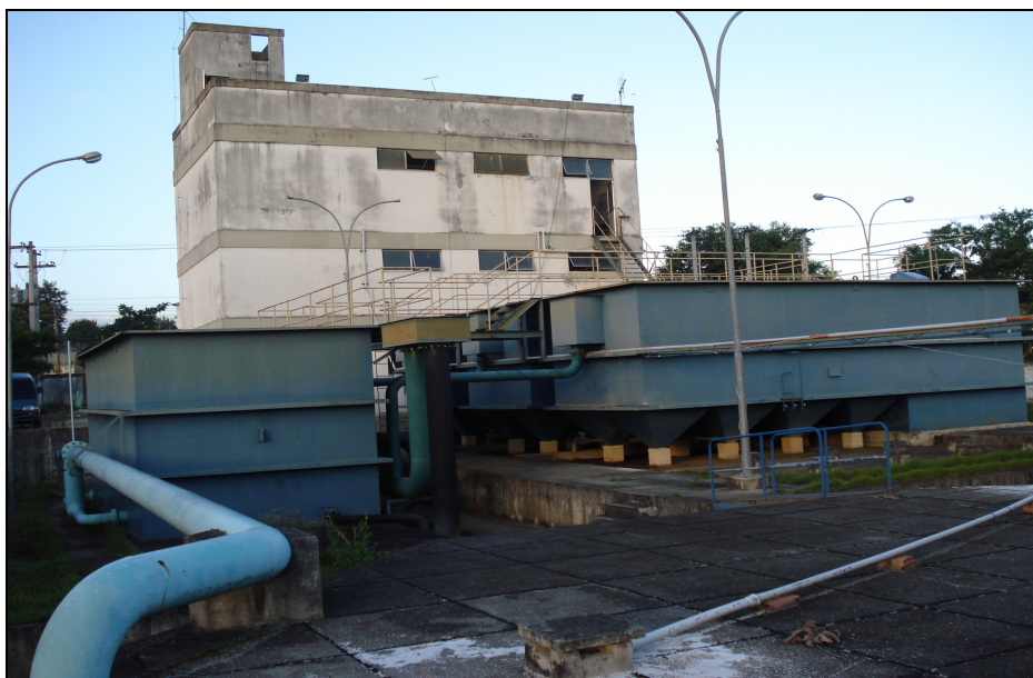
Figura 6.9 – Vista da ETA 4. Fonte: Arquivo do Autor (2006).
