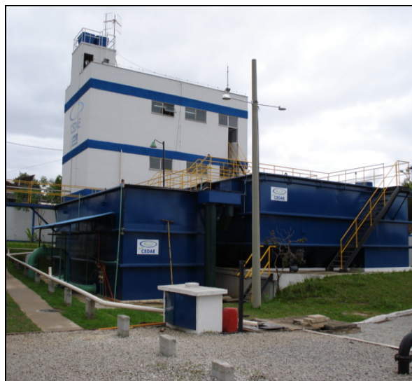
Figura 6.8 – Vista do Prédio da ETA 3. Fonte: Arquivo do Autor (2007).
