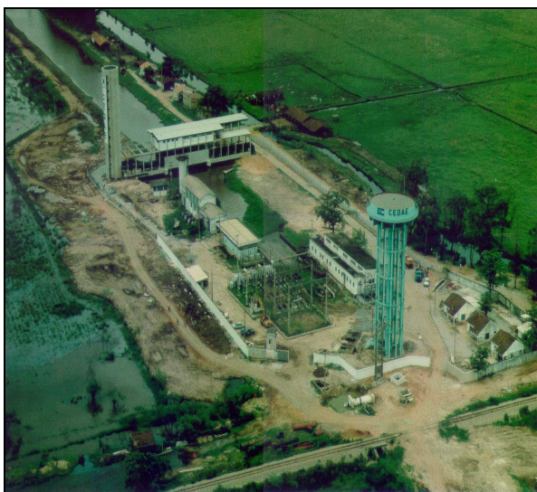
Figura 6.7 – Captação no canal Imunana Rio Guapi-Macacu. Fonte: Arquivo do Autor (2007).
