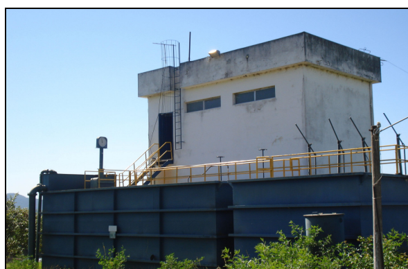
Figura 6.6 - Vista do Prédio da ETA 2. Fonte: Arquivo do Autor (2006).
