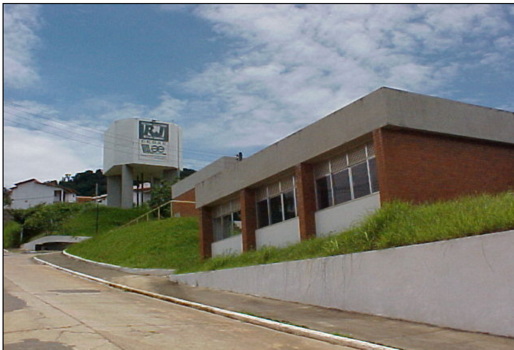
Figura 6.16 – Vista da ETA 6. Fonte: Menezes (2006).
