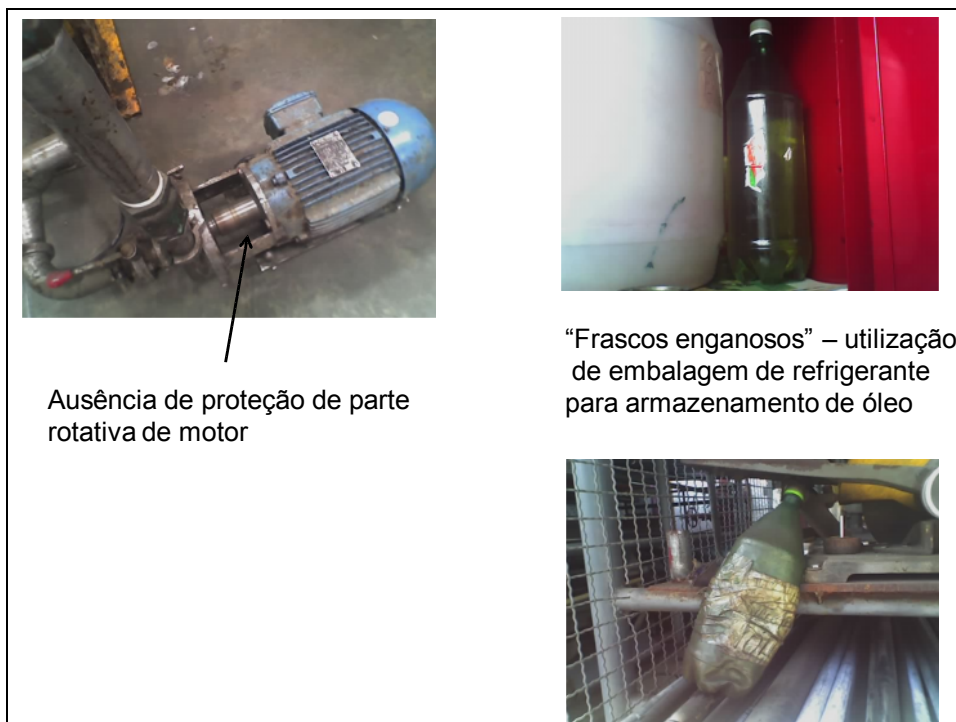
Figura 13 - Condições de risco
