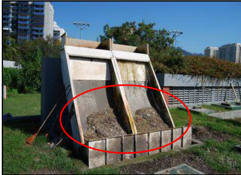
Figura 5.7 – Vista frontal de uma peneira estática com acúmulo de resíduos e contaminação do solo.
