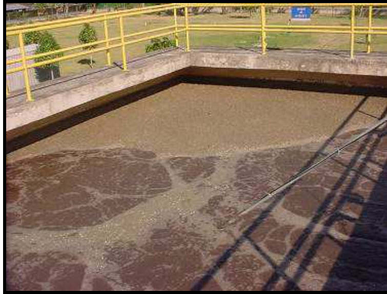
Figura 5.12 – Vista de um tanque de aeração não homogêneo, apresentando espuma oriunda de bactérias filamentosas.
