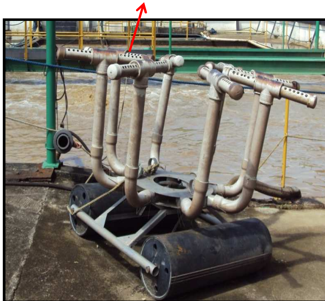
Figura 5.13 – Vista de um aerador improvisado.
